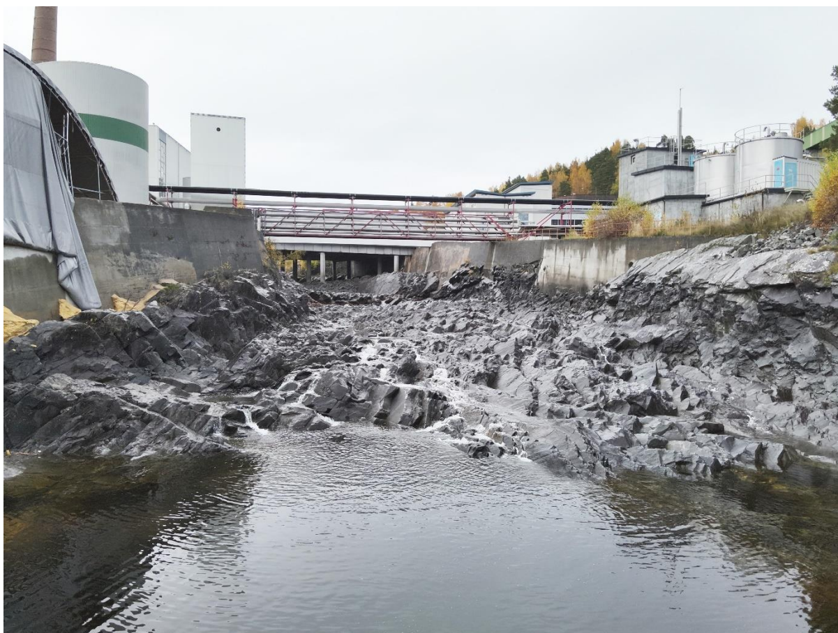
Figur 2.6. Litt lekkasjevann eller dreneringsvann renner i elvebunnen og inn i bassenget for undervann til Hofsfoss kraftverk. Elvebunnen består av fjell.
