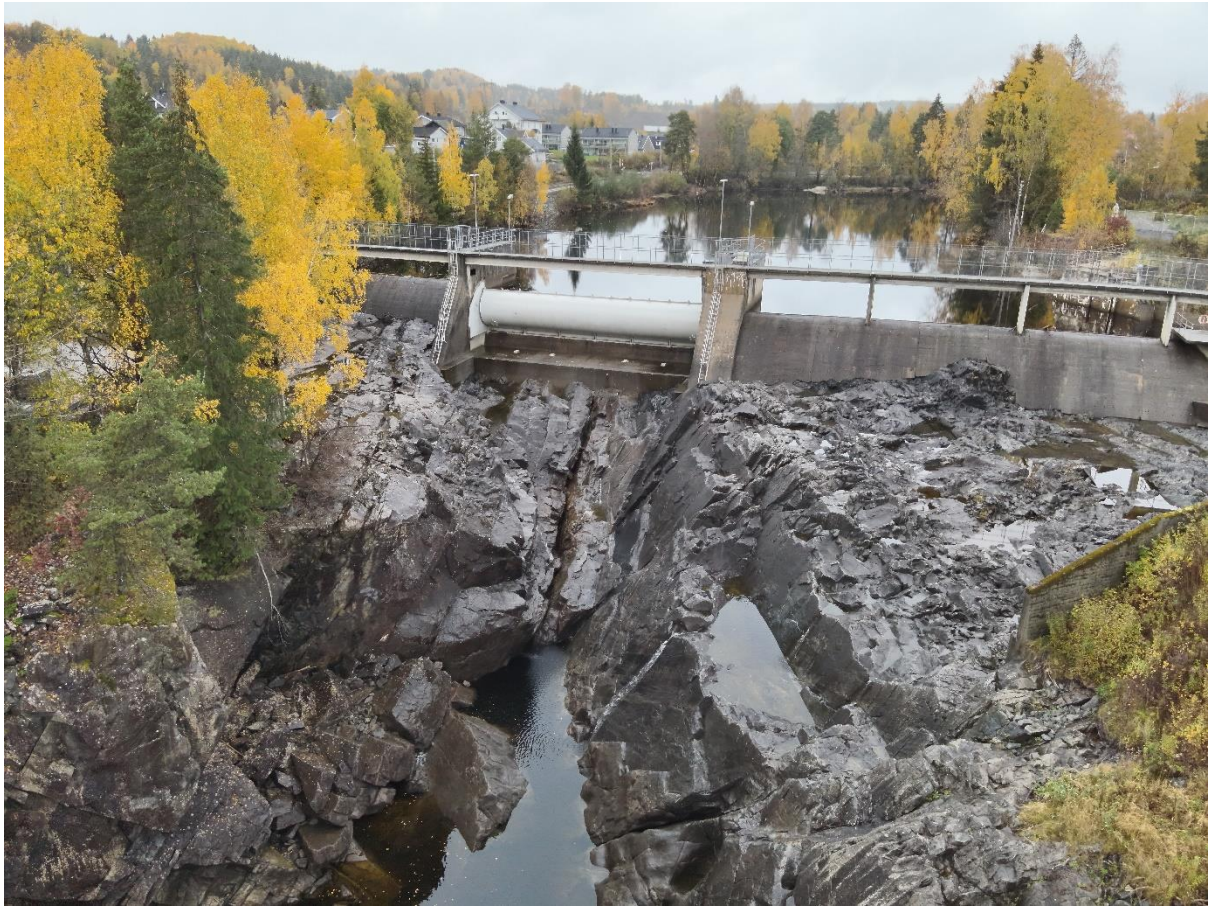
Figur 2.1 Inntaksdam og tørt fossefall slik det er mesteparten av året.
