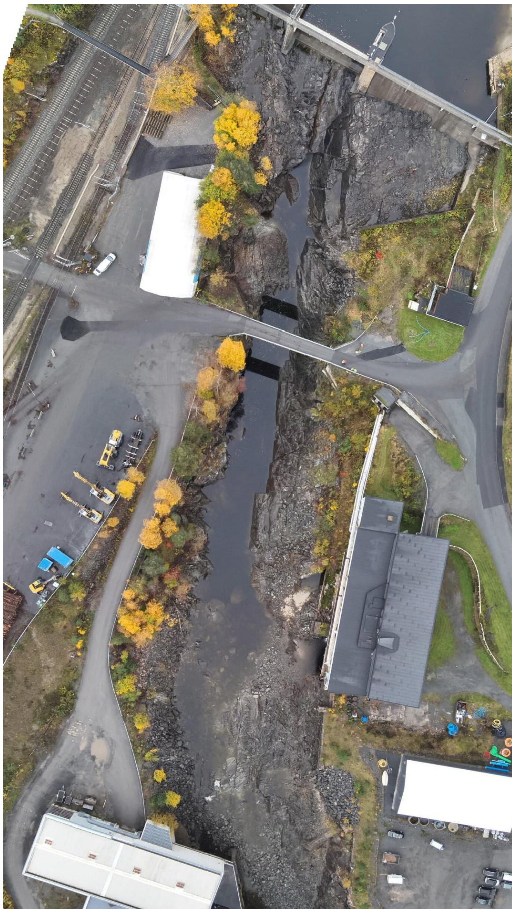
Figur 2.2. Strekingen fra dammen og ned til der elva passerer under et industribygg.
