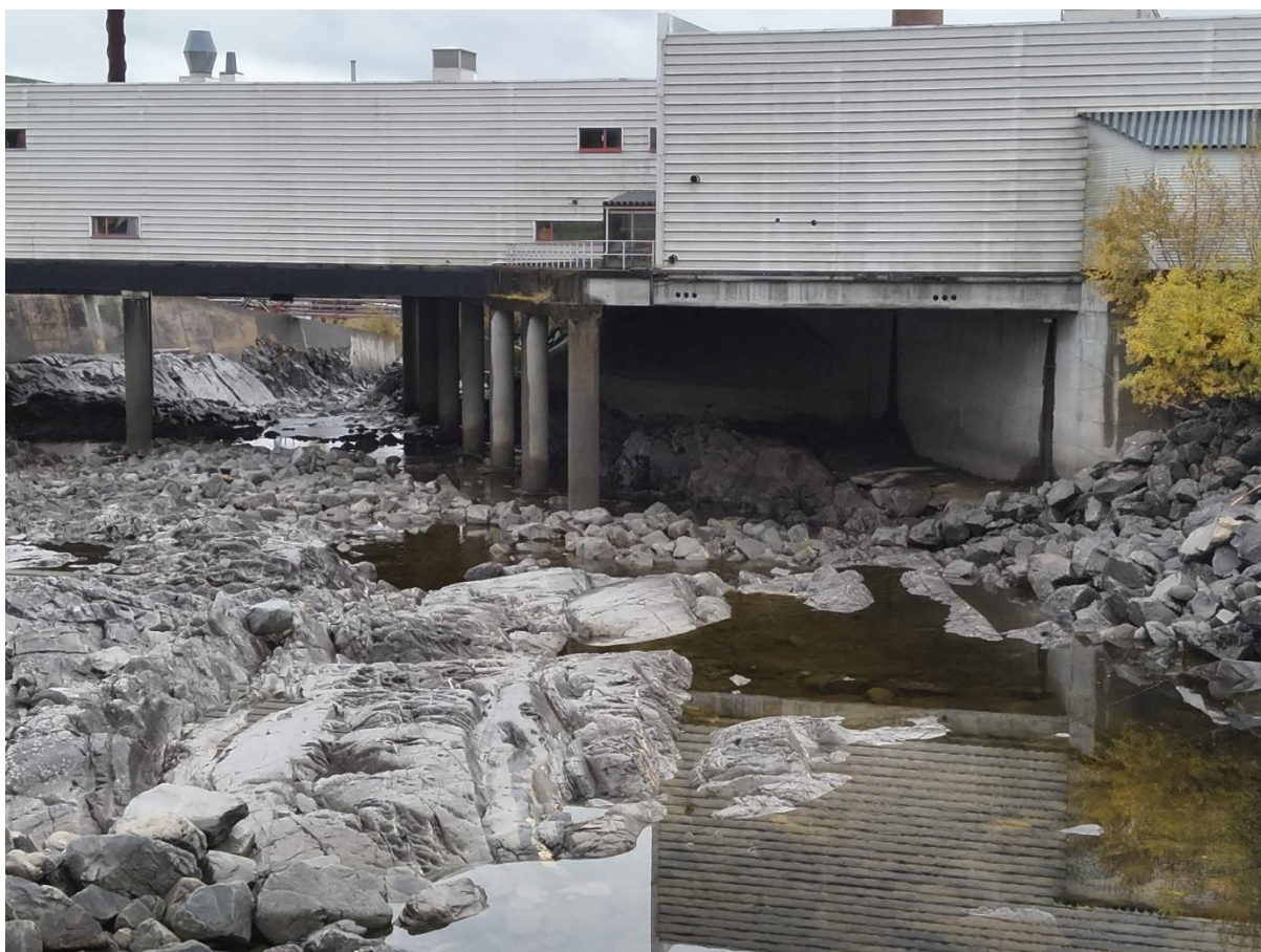
Figur 2.3. Her passerer elva under industribygget. Bunnsstrat av grov stein og fjell indikerer store vannhastigheter i flomperiodene.
