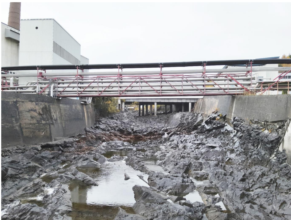
Figur 2.5. Elveløpet på strekningen mellom industribygget og undervann kraftverket. Elvebunnen består av bart fjell og elveløpet er kanalisert med hjelp av betongvegger.
