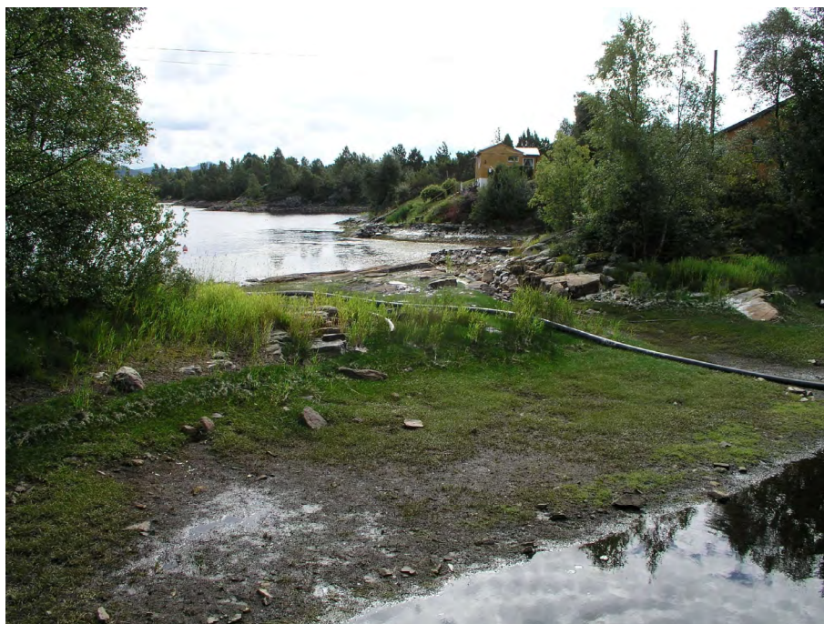
Foto tatt august 2006 av tørrlagt område mellom vann og kanal. Synlige tappeledninger (Mowi), nedtappet, stygt område mellom hytte-eiendommer og vann.
