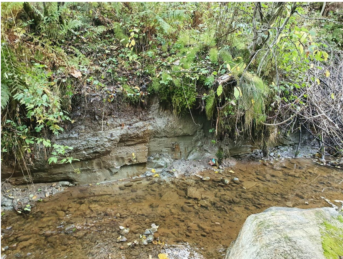
Figur 4-4: Bilde fra Uldegrova som viser blottlagt leire og erosjon i bunn av skråningen mot nordøst.
