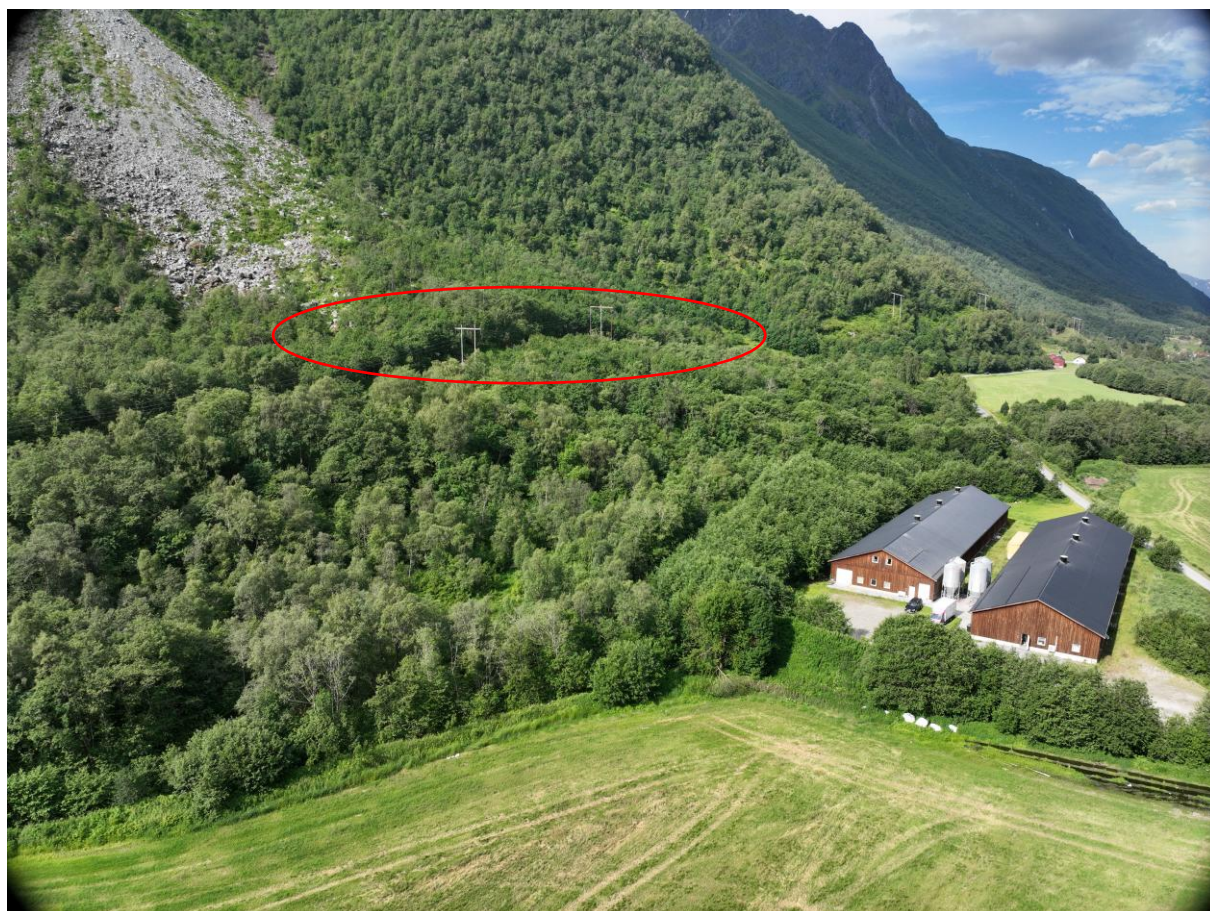
Bilde 1: Dronebilde som viser skredviften med ledningen i forkant, markert med rødt.
