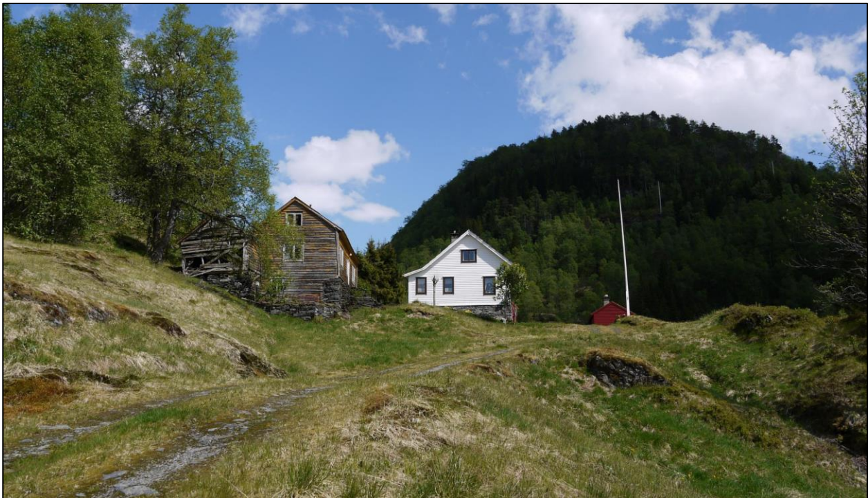
Figur 4-42. Steinhushaugens gårdstun med våningshus 1242-0006-016 og våningshus 1242-0006-017: Foto: SEFRAK-registrering 2014
