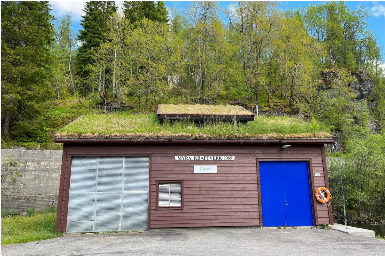
Figur 4-24. Myra kraftverk. Foto: Sweco.
