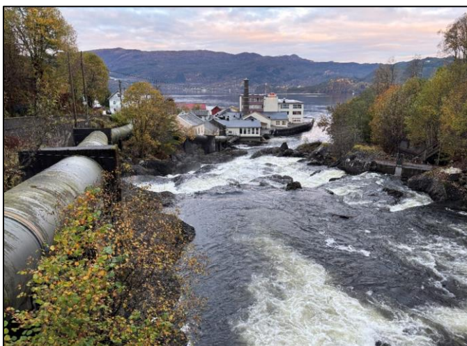
Figur 4-52. Fabrikken sett fra Tyssefossen med synlig rørgate. Foto: Sweco
