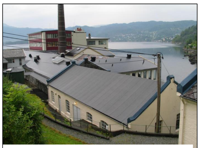
Figur 4-51. Kraftstasjon ved Ytre Tysse 1242-0009-065. Foto: SEFRAK-register, 2004.
