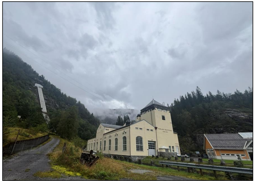
Figur 3-3. Frøland kraftverk i dag. Foto: Sweco
