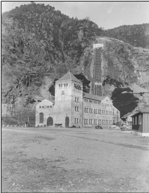
Figur 3-4. Frøland kraftverk, trolig tatt i 1928. Foto: Atelier KK, Universitetsbiblioteket i Bergen.
