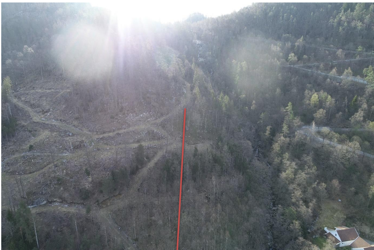
Bilde 6 – Nedre delar av vassveg mot kraftstasjon
