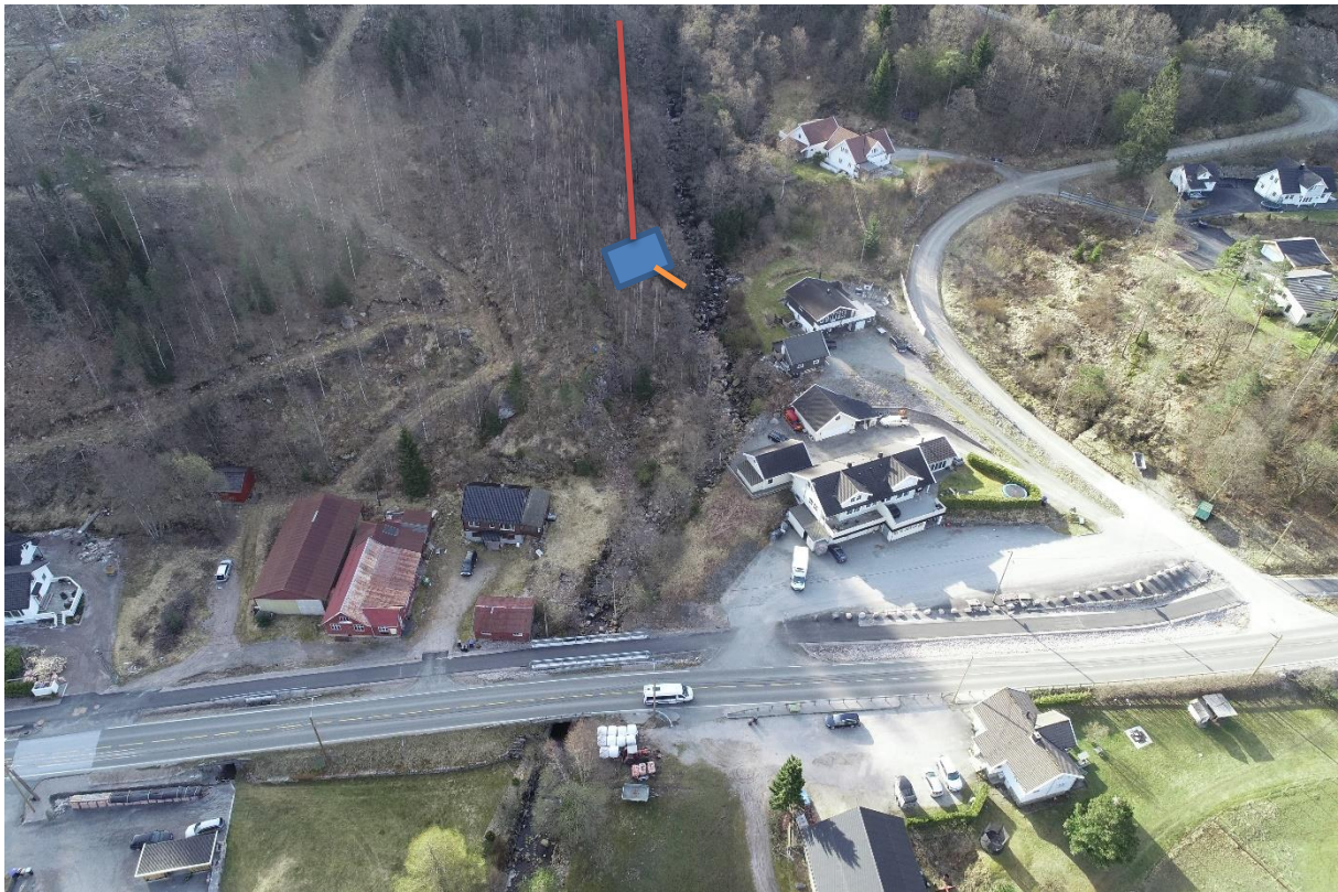
Bilde 7 – Oversiktsbilde over kraftstasjonsområde med om lag plassering av stasjon, eksisterende bygninger og infrastruktur
