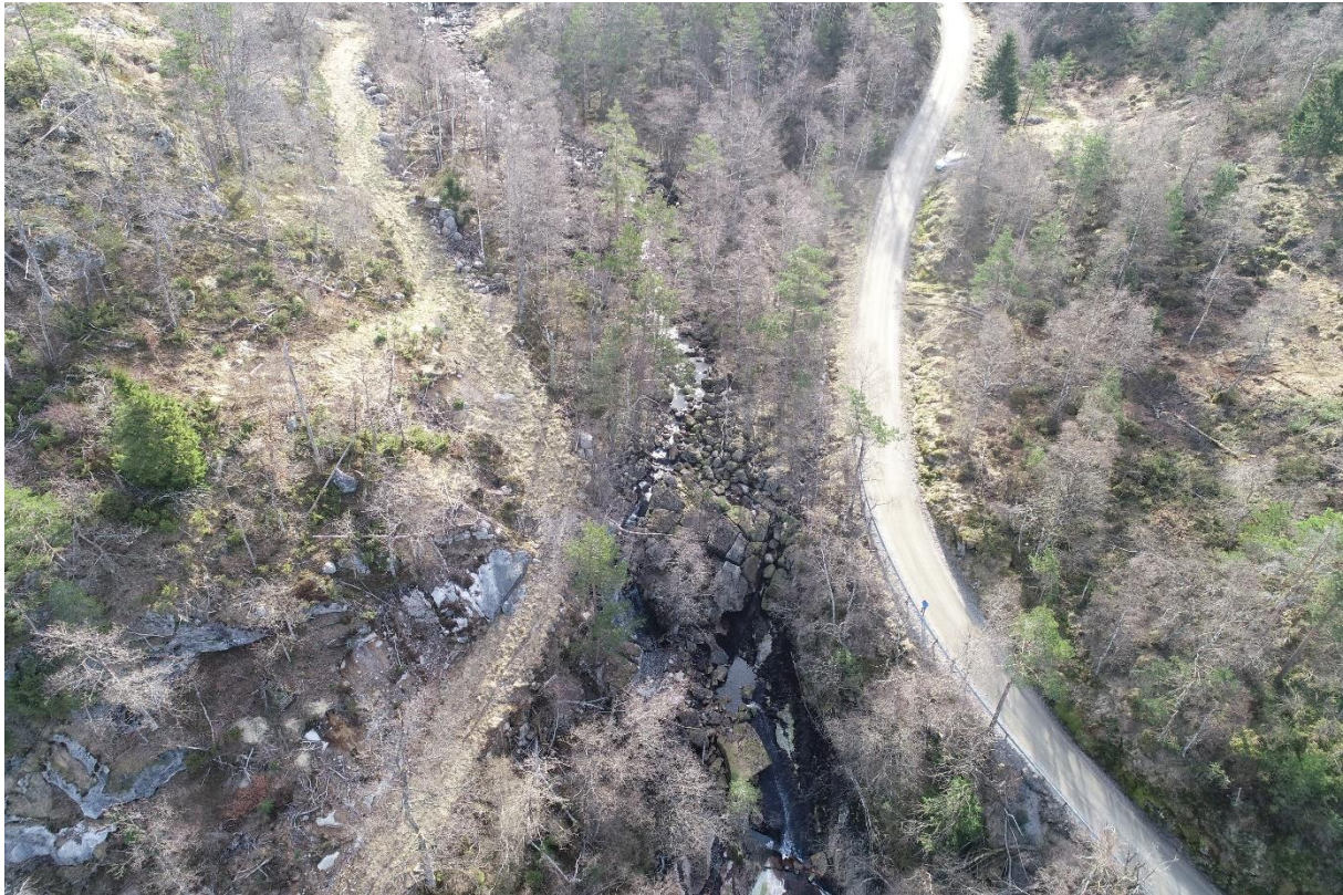
Bilde 3 – Inntaksområde, første del av rørtrasè og tilkomstveg. Bend er planlagt i skogsveg (sving) til venstre
