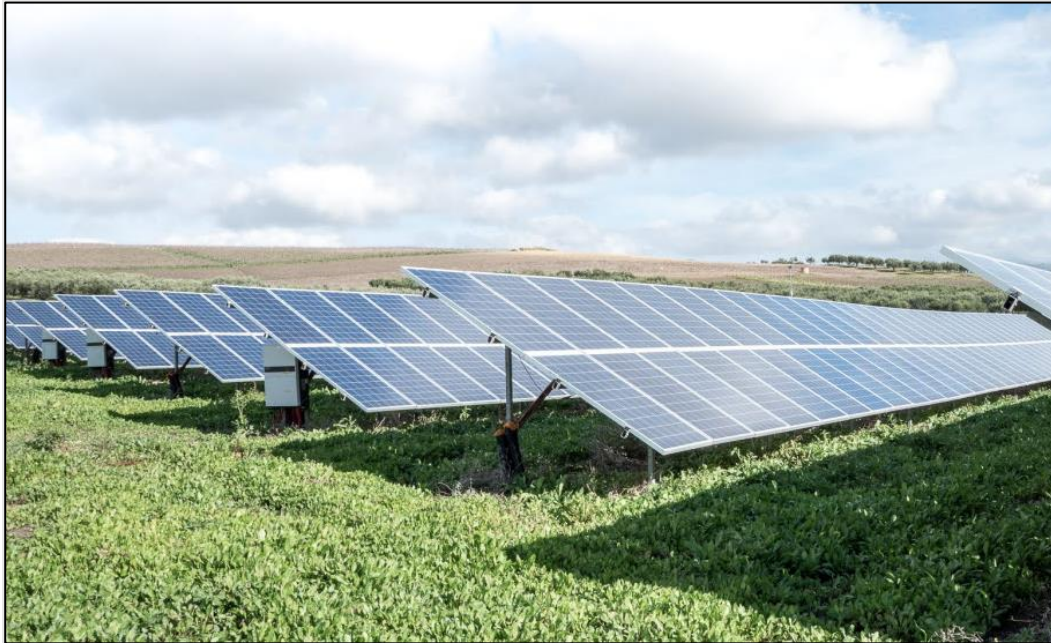
Figur 4: Illustrasjon festestruktur og rader i solkraftverk (Kilde: Shutterstock)
