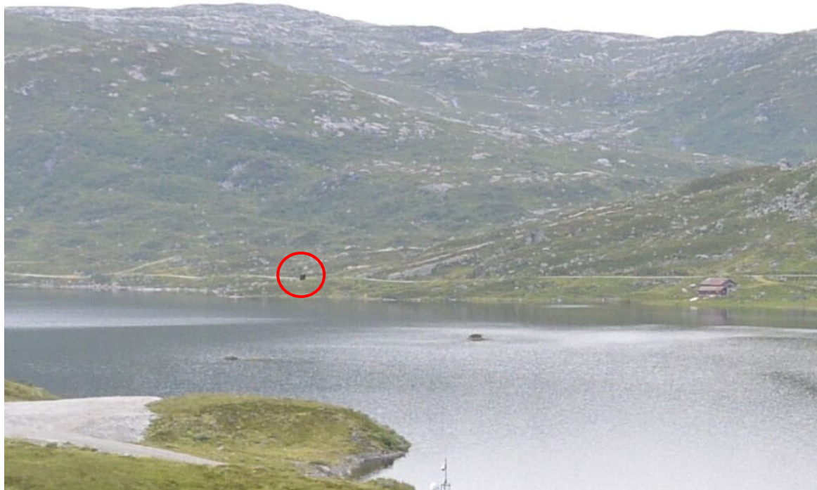
Figur 20 Nettstasjon Stordalen sett fra sørøstsiden av Fossvatn. Lonestølen til høyre. (Multiconsult)
