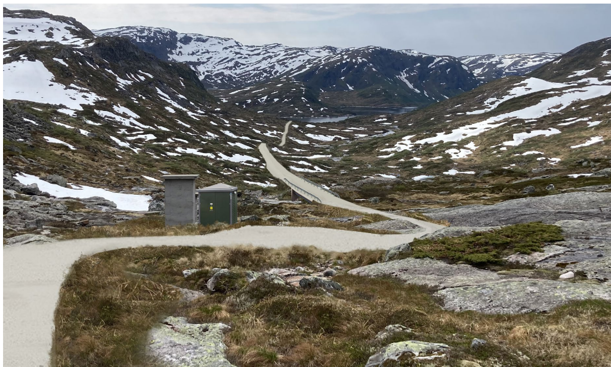
Figur 22 Nettstasjon dam Seltuftvatn sett fra nord. Bygget til venstre er lukehuset til dammen. Veien er også tegnet inn. (Multiconsult)
