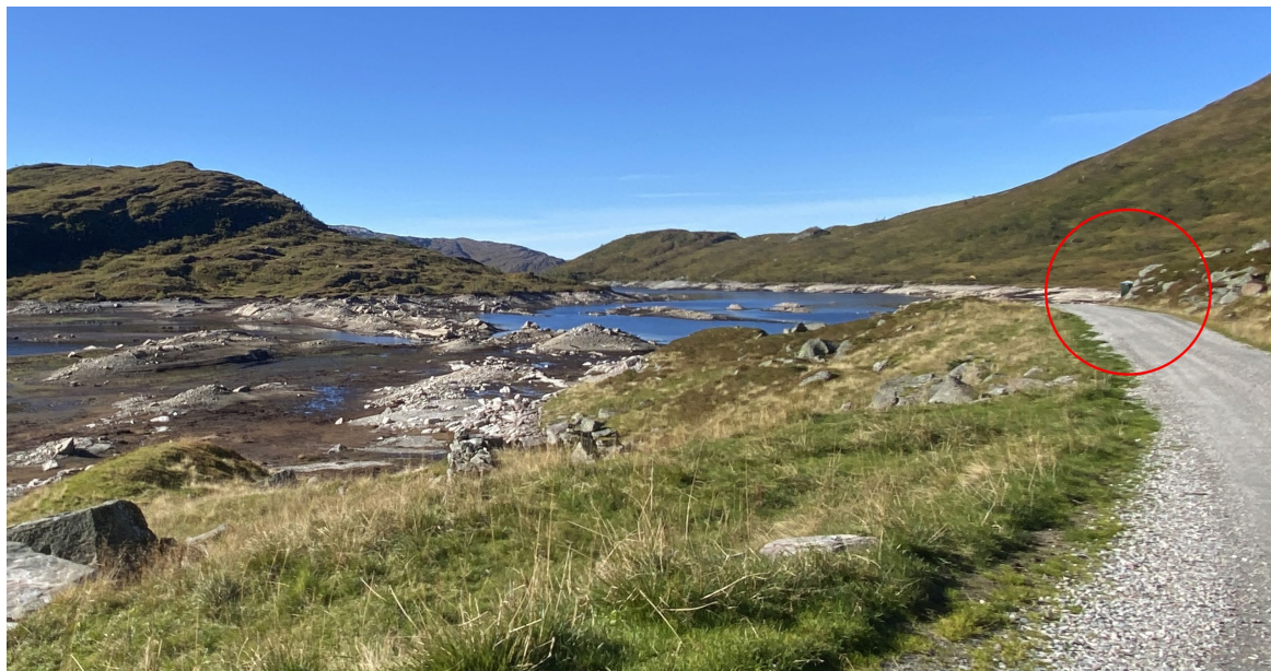
Figur 21 Nettstasjon Stordalen sett fra Lonestølen. (Multiconsult)
