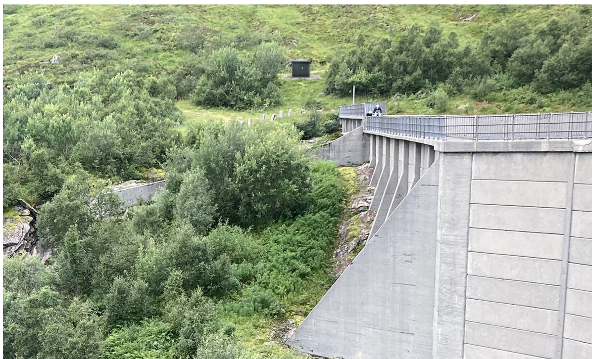
Figur 23 Nettstasjon dam Fossvatn sett fra østsiden av dammen. (Multiconsult)
