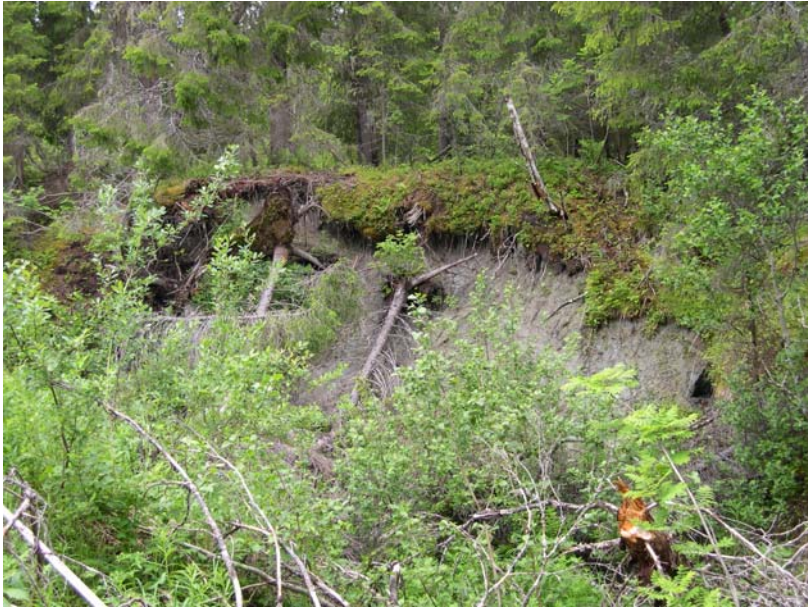
Bilde 1: Erosjonskant nedstrøms P50. På toppen av skråning som ligger til venstre for hvor bildet er tatt, er det flere bolighus.
