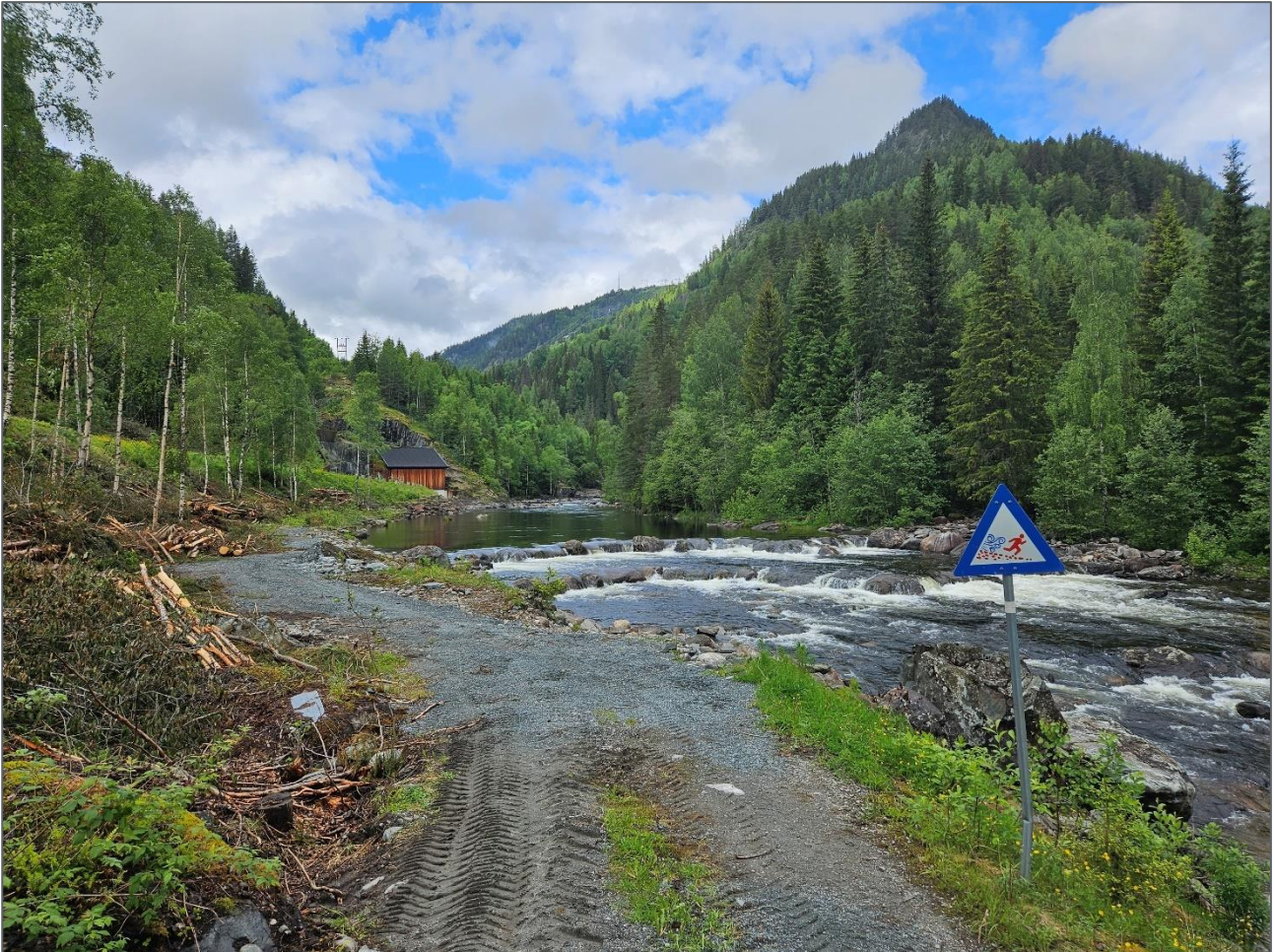
Figur 4-11: Kulp og fiskeplass ved Rødberg kraftverk. Foto tatt mot vest.
