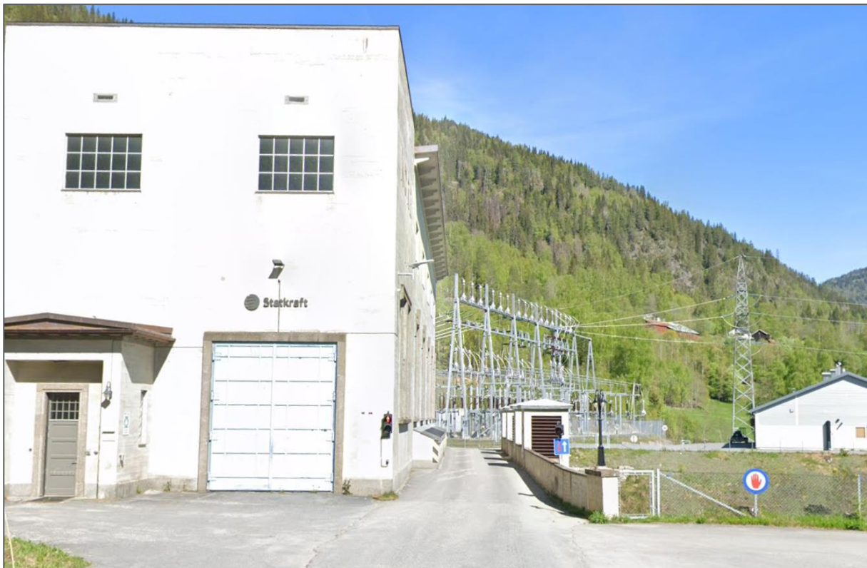
Figur 8-9: Kryssing av utløp ved Nore II kraftverk. Foto tatt mot nord.
