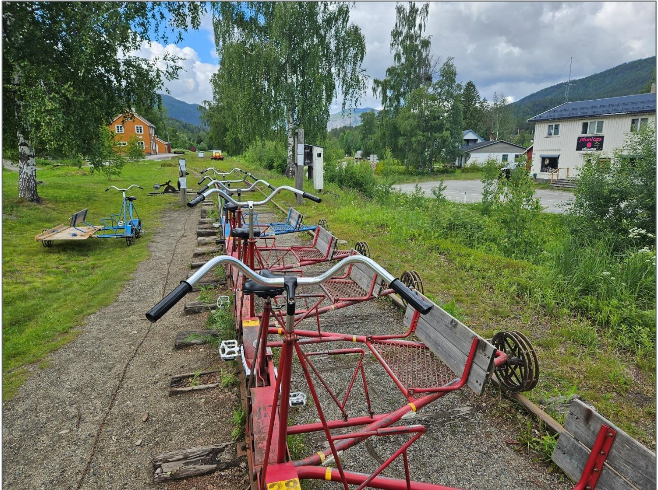
Figur 8-1: Numedalsbanen ved Veggli.
