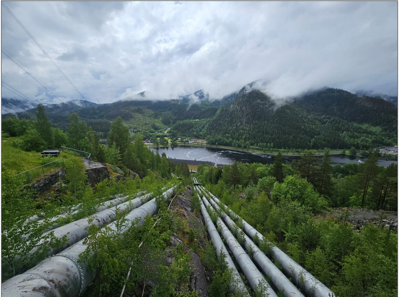
Figur 4-9: Bilde fra rampe over den gamle rørgata, med utsikt over Rødbergdammen. Rasteplass ved turveien kan sees til venstre, og fortsettelsen av stien kan skimtes til høyre i bildet. Foto tatt mot sør.
