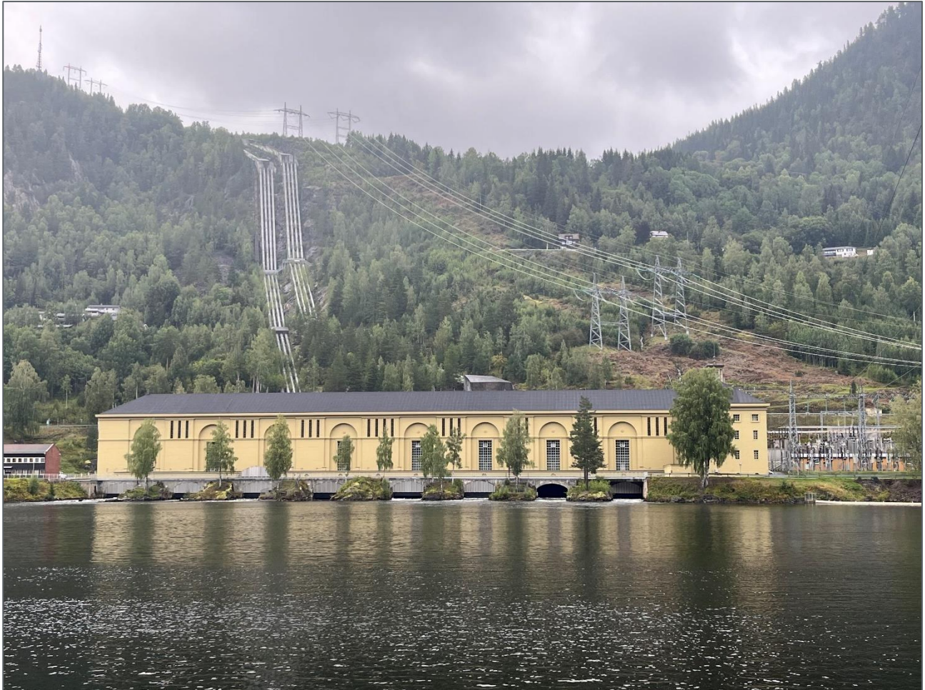
Figur 8-3: Nore I kraftverk med rørgate. Foto tatt ved fv. 40 mot nord.
