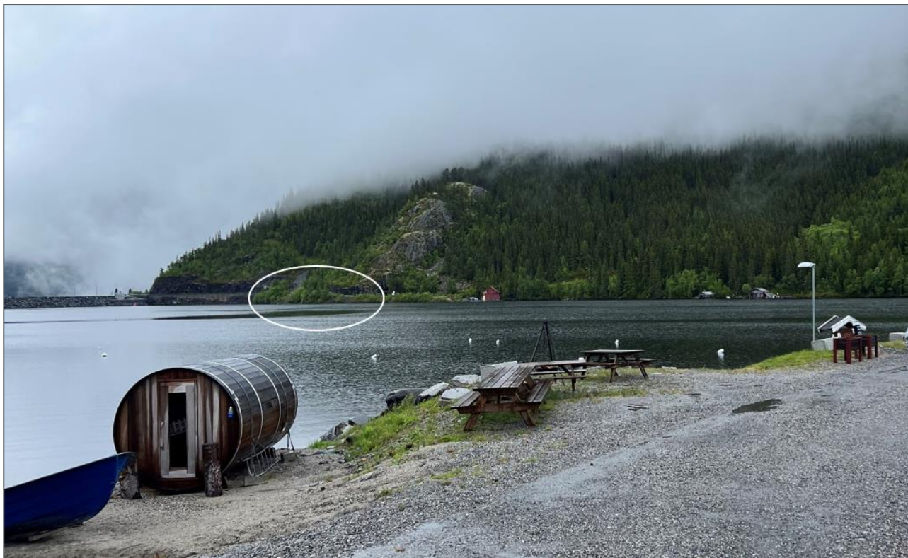
Figur 5-1: Inntak blir dykket til venstre for rødt bygg midt i bildet (innringet). Foto tatt mot sørøst fra Sagodden.
