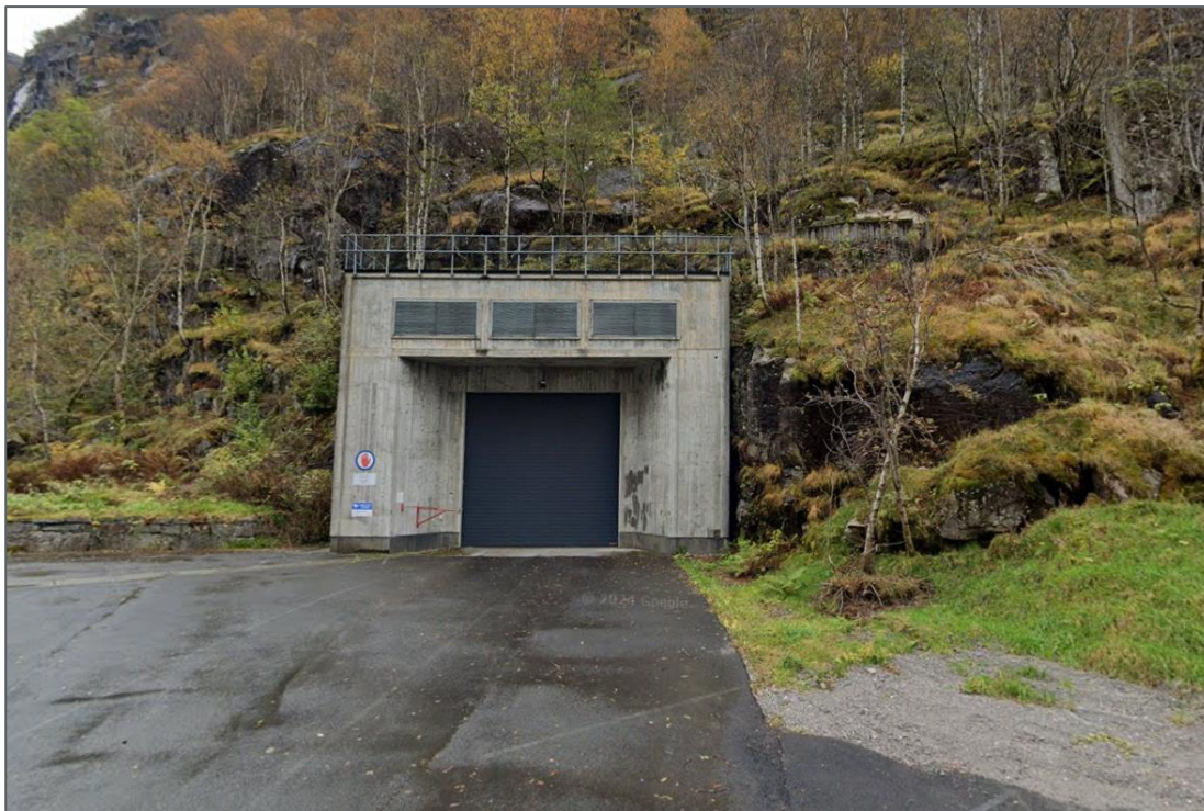
Figur 8-7: Eksempel på atkomsttunnel Admed betongkonstruksjon i forkant. Her fra Mauranger kraftverk, hentet fra Google streetview.
