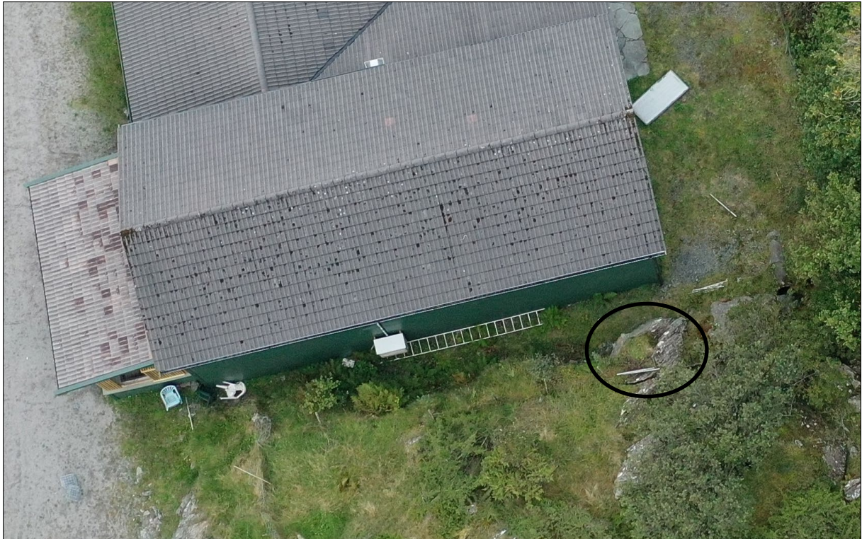
Figur 25: Bilde av bratt fjellknaus ved infopunkt 1, sett ovenfra. Avstanden mellom fjellknausen og husveggen er omtrent 1 m.
