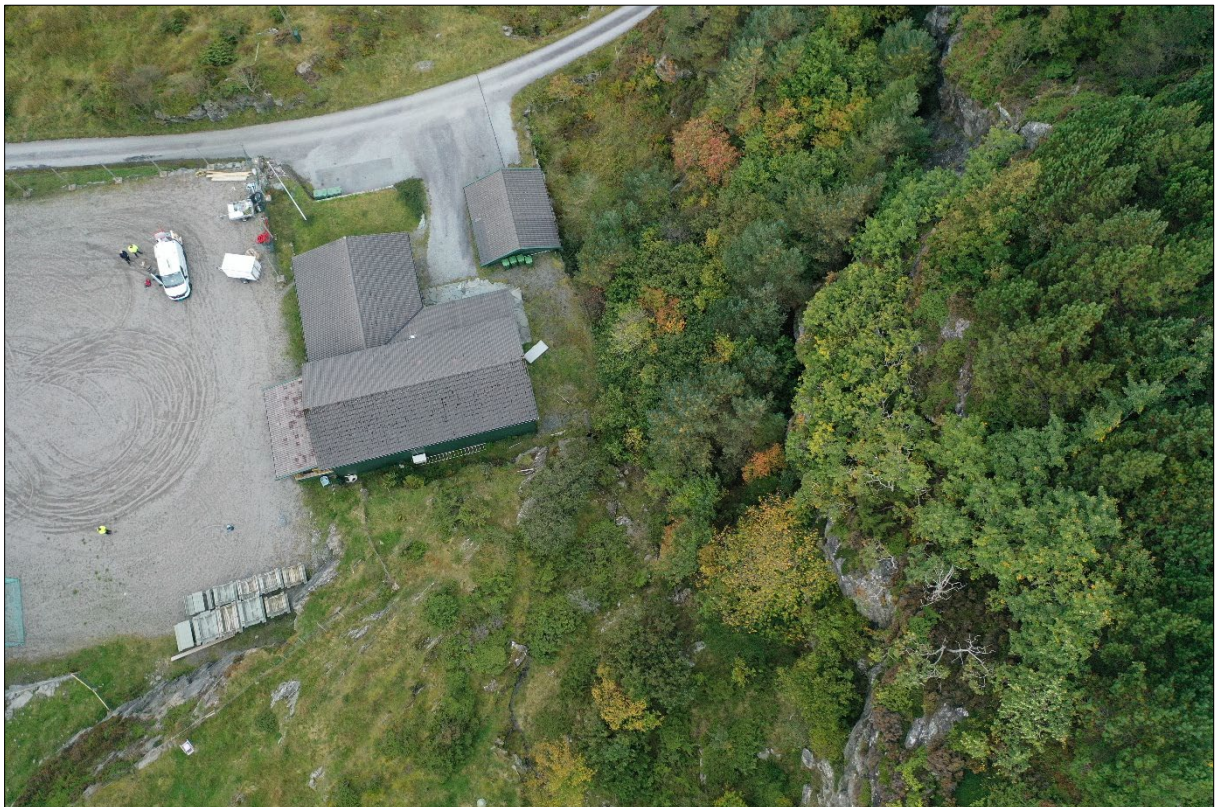
Figur 3: Nærbilde av kartlagt området og byggene her. Fjellskrenten nord for kartlagt område (til høyre i bildet) er tilnærmet vertikal.
