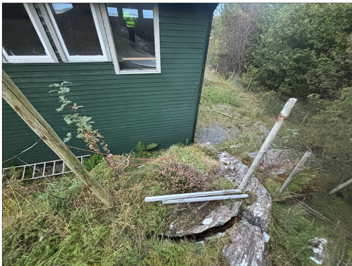
Figur 24: Bilde av bratt fjellknaus ved infopunkt 1, sett ovenfra. Fjellknausen er vurdert som ustabil, med løsnestannynlighet > 1/100 per år.
