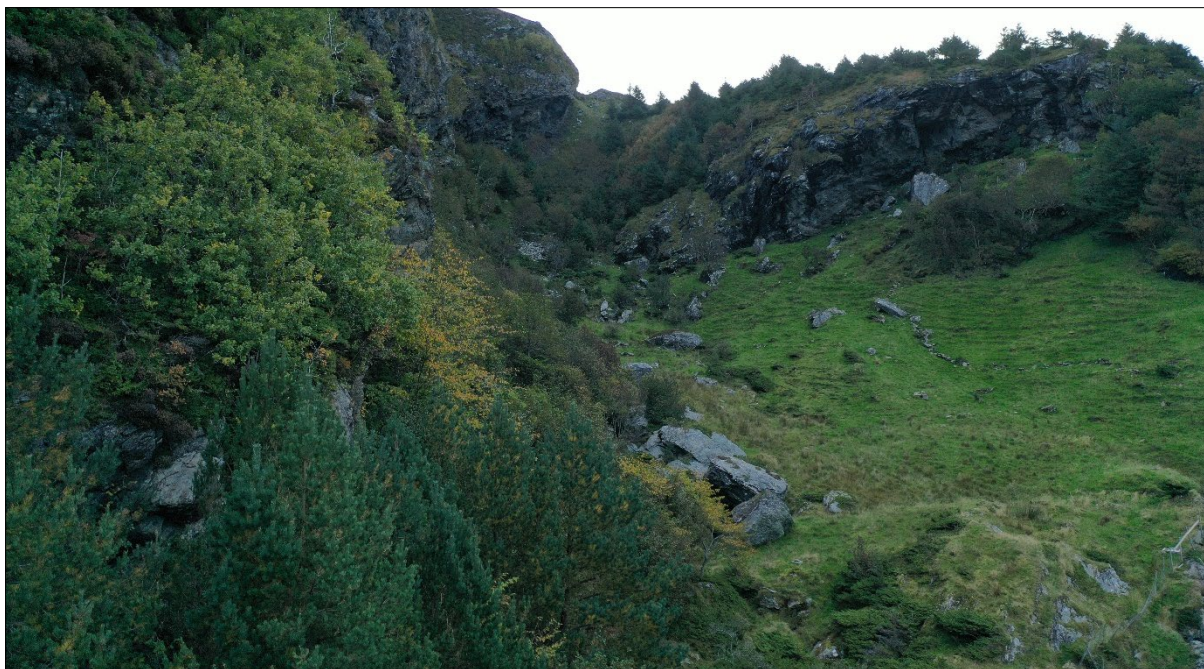
Figur 11: Bratt fjellskrent i sørvestlige del av påvirkningsområdet. Fremfor fjellskrenten er det registrert flere steinsprangblokker som har stoppet i kort avstand fra skråningsfot, der terrenget slakker ut.
