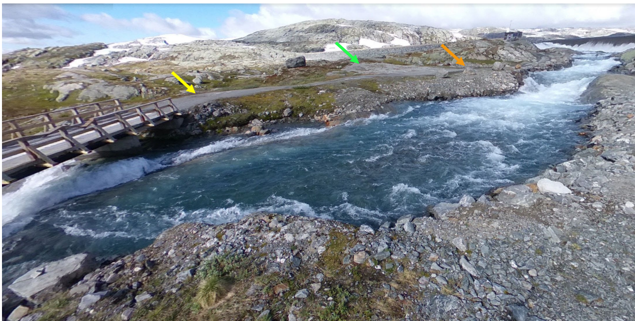
Figur 4.3 Område for permanent utvidelse av vei og jordmasser til mellomlager indikert med gul pil. Steinblokker (orange pil) og grusplass (grønn pil) for mellomlager kan ses i bakgrunn (Google maps).
