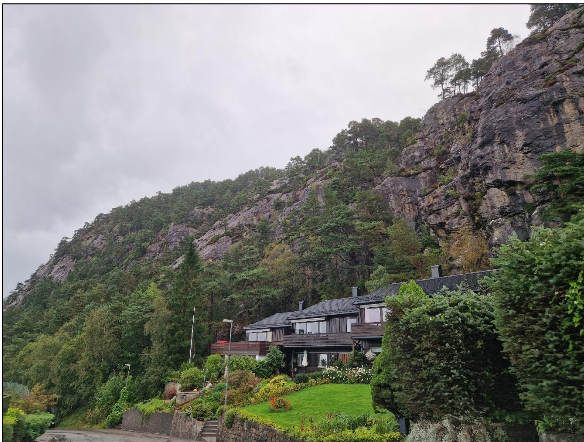
Figur 12. Fjellside i påvirkningsområdet samt sikret parti over Ravnestølen 100-104. Sett mot nordøst. Det er sikringstiltak (bolter) i berget bak bebyggelsen.
