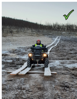
Figur 10: Eksempel på etablert terrengforsterkning over bløte partier.
