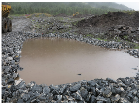
Figur 43: Prosjektert sedimentasjonsbasseng. Utløpet er neddykket for at eventuelle oljerester skal kunne samles opp på overflaten i bassenget.
