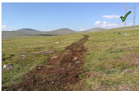
Figur 36: Godt istandsatt kjørespor.
