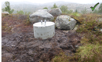
Figur 20: God overgang mellom stabbe og terreng.
