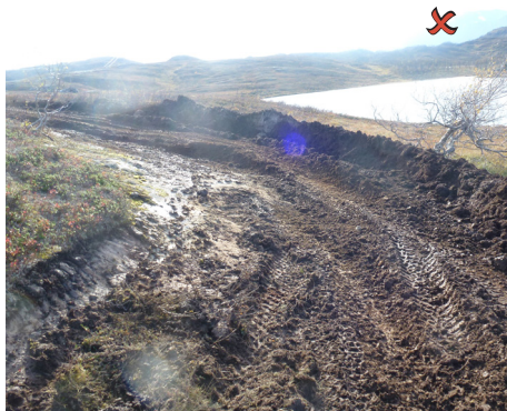
Figur 9: Bøte og bæresvake partier skal ikke graves til side for å lette transporten. Det oppstår da fare for uttørring av tilstøtende arealer.
