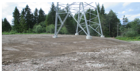
Figur 28: Mastepunkt som er tilbakeført som en stor glatt flate. Her burde flaten vært brutt opp ved å lagd forhøyninger og forsenkninger. I tillegg burde det vært plassert ut vegetasjonstuer for at naturlig vegetasjon raskere kan reetableres.
