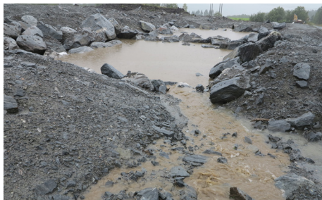
Figur 40: Eksempel på konstruert sedimentasjonsbasseng for avrenning fra stasjonstomt. Utløpet er neddykket slik at eventuelle oljerester legger seg på overflaten.
