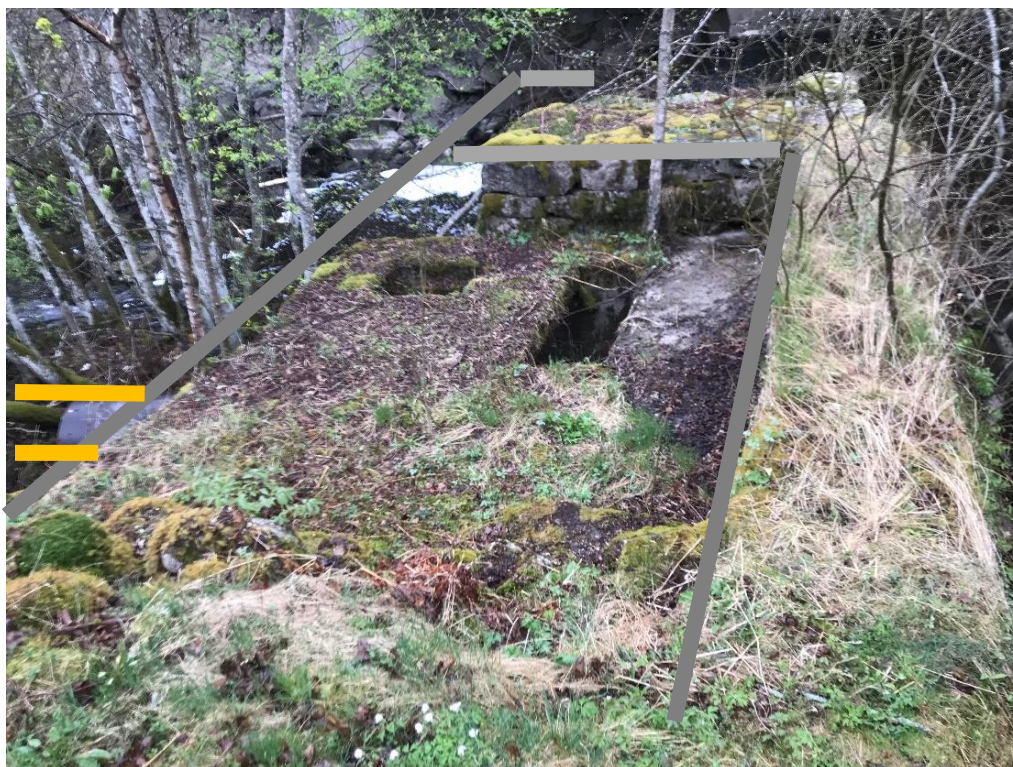
Bilde 7: Viser dam fra venstre vederlag med deler inntak med inntaksrør ved Brekke Mølle. Eksisterende damanlegg er relativt godt begrodd. Bilde viser området hvor ny inntakskonstruksjon etableres. Gule streker indikerer rørgate og grå oppgradering av inntak med ny betong.
