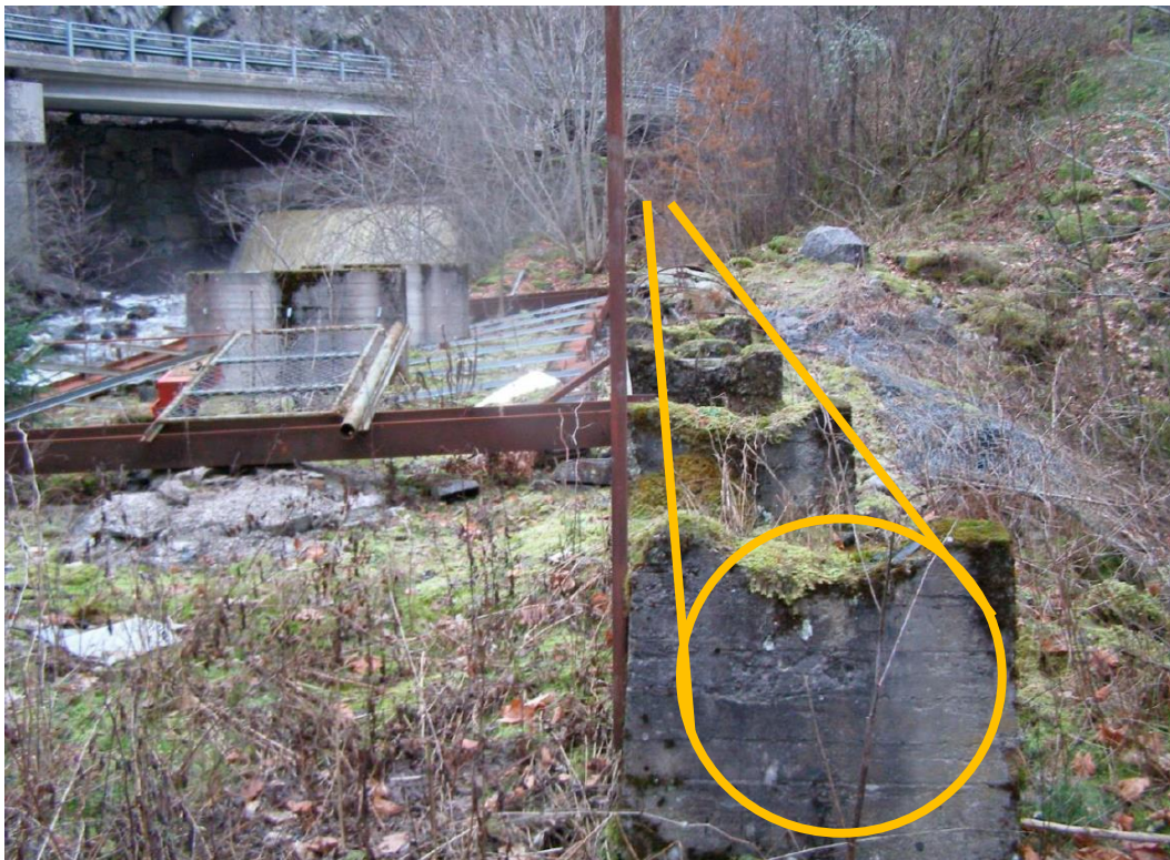
Bilde 5 Viser rester etter rørfundamenter mellom inntaksdam og Brekke kraftverk, ny vannvei vil benytte samme trase som er brukt tidligere, fram til bygninger. Gule streker viser rørgate.
