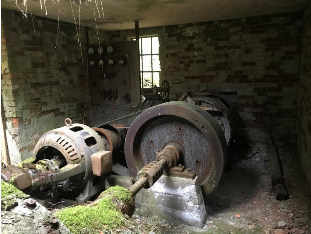
Bilde 1: Brekke kraftstasjon slik den ser ut i dag. Det er noen år siden denne stoppet.
