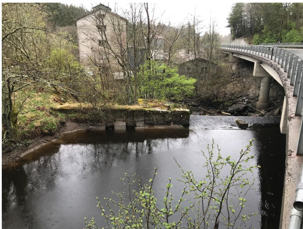
Bilde 8 Tatt i fra fylkesveien. Viser hvor tett inn på vassdraget vei og bygningsmasse ligger. Bilde viser også hele damanlegget i full lengde med unntak av 1m av høyre damvederlag som er skjult av veibanen.
