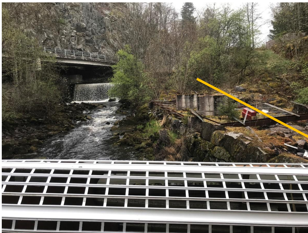
Bilde 3: Viser berørte elvestrekning, i fra dam til avløp rett i nedkant av bilde, elvestrekning ca. 40m. Gul strek viser rørgateplasing.
