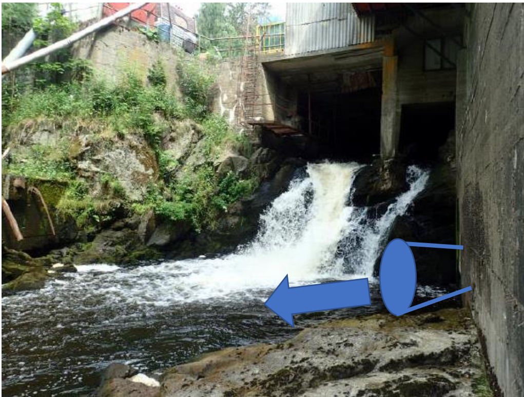
Bilde 2 Viser Brekkefossen som er et naturlig vandringshinder for fiske. Registrert elveperlemusling populasjon er funnet 30m-40m nedstrøms fossen. Bilde viser også planlagt avløpsplassering i fra kraftstasjon i fra bygning til høyre i bilde. Blå pil indikerer avløp i fra krafstasjon.
