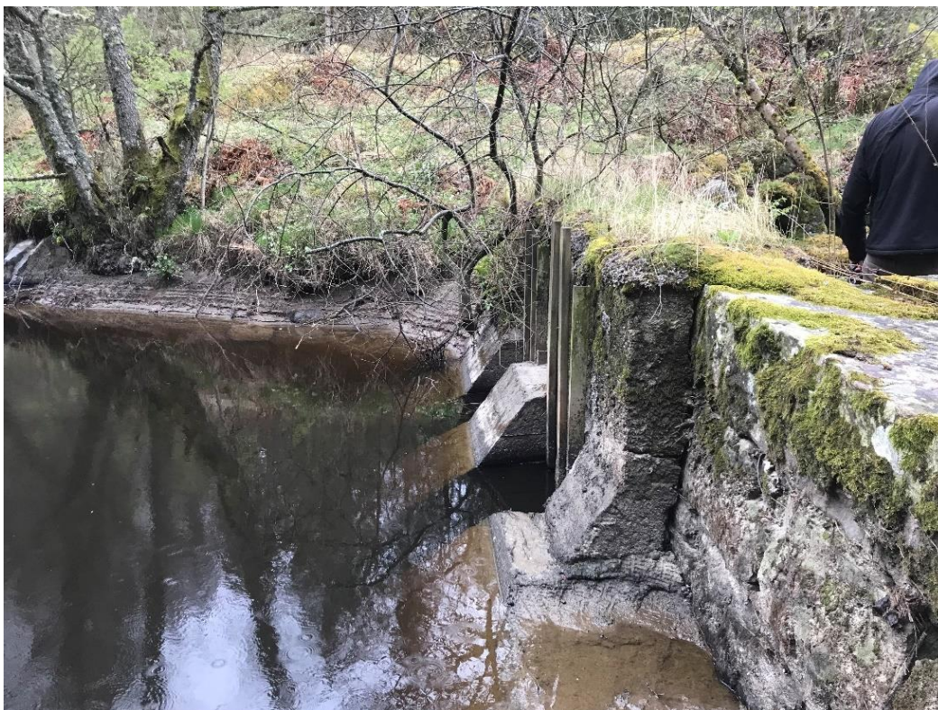
Bilde 6: Eksisterende dam er ca. 2,0-2,5m høy, sett fra inntaksmagasin med to luker.
