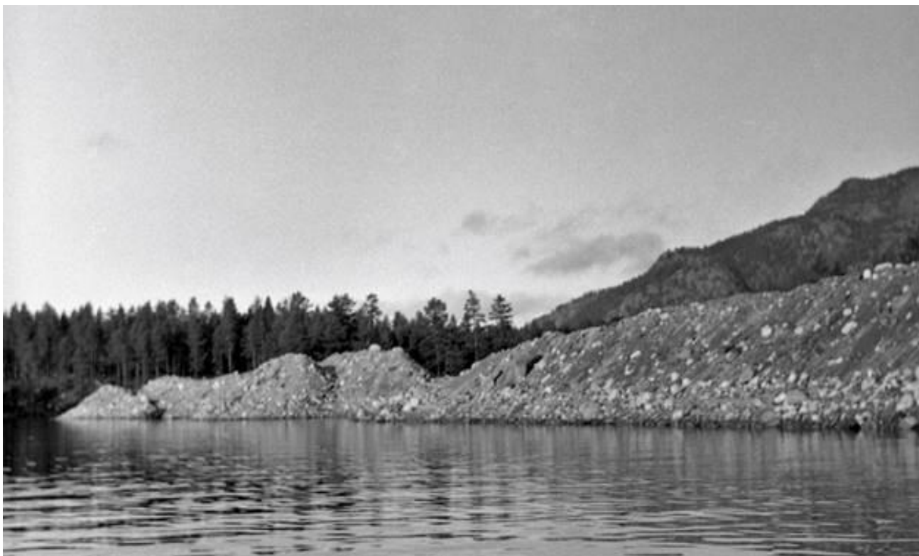
Figur 10. Botnmasse fjerna frå hovudløpet i Vassenden ved Surtefoss/ Døletorv (Fossane) hausten 1956. (Foto: Reidar Larsen/K.J.Alværn). I dette området var eit av dei beste notdraga kalla «Fossen» før regulering av fjorden.
