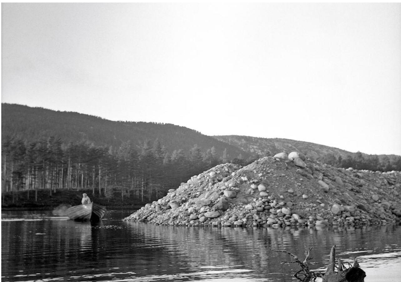
Figur 11. Botnmasse fjerna frå hovudløpet i Vassenden ved Surtefoss/Døletorv (Fossane) hausten 1956 (Foto: Reidar Larsen/K.J.Alværn). I dette området var eit av dei beste notdraga kalla «Fossen» før regulering av fjorden.
