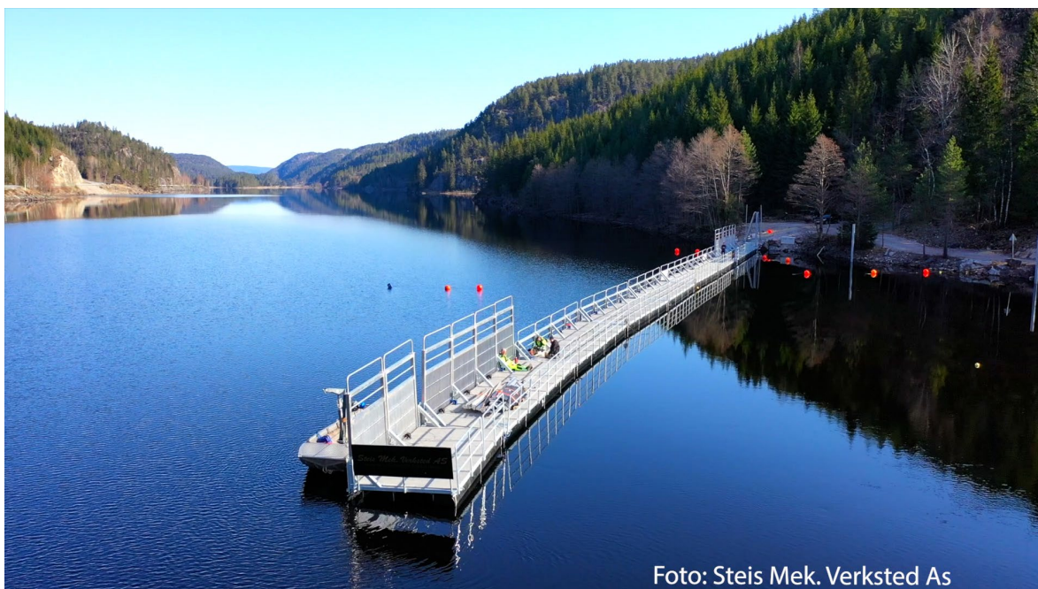
Figur 4. Ledegjerdet for smolt oppstrøms inntaket til Laudal kraftverk. De ytterste grindpanelene er hevet mens resten står i driftsposisjon.
