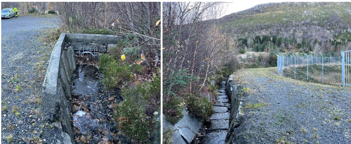
Figur 13: Grøft rundt stasjonen og ned på austsida.
