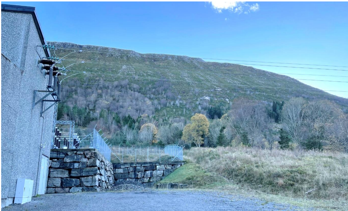
Figur 5: Vestsida av stasjonen.
