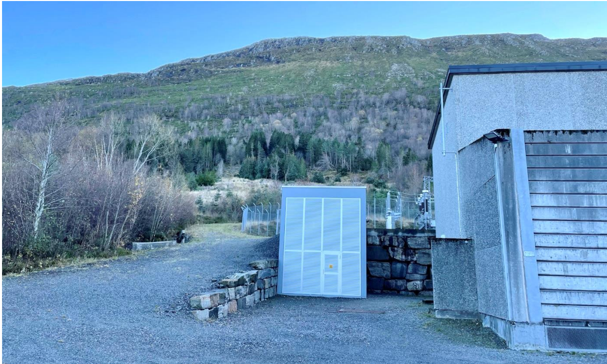
Figur 4: Austsida av stasjonen.
