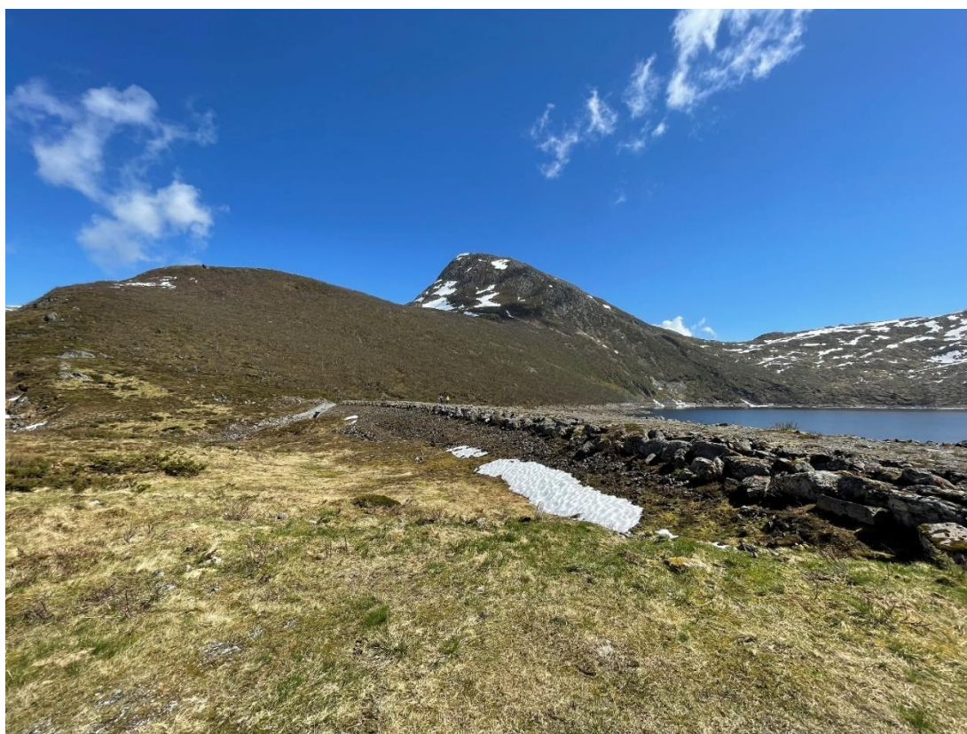
Figur 4-4 Dam Kvanndalsvatn nord, fra nedstrøms side
