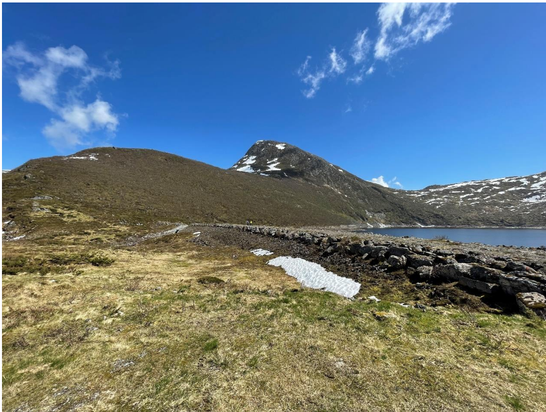
Figur 8 Dam Kvanndalsvatn Nord
