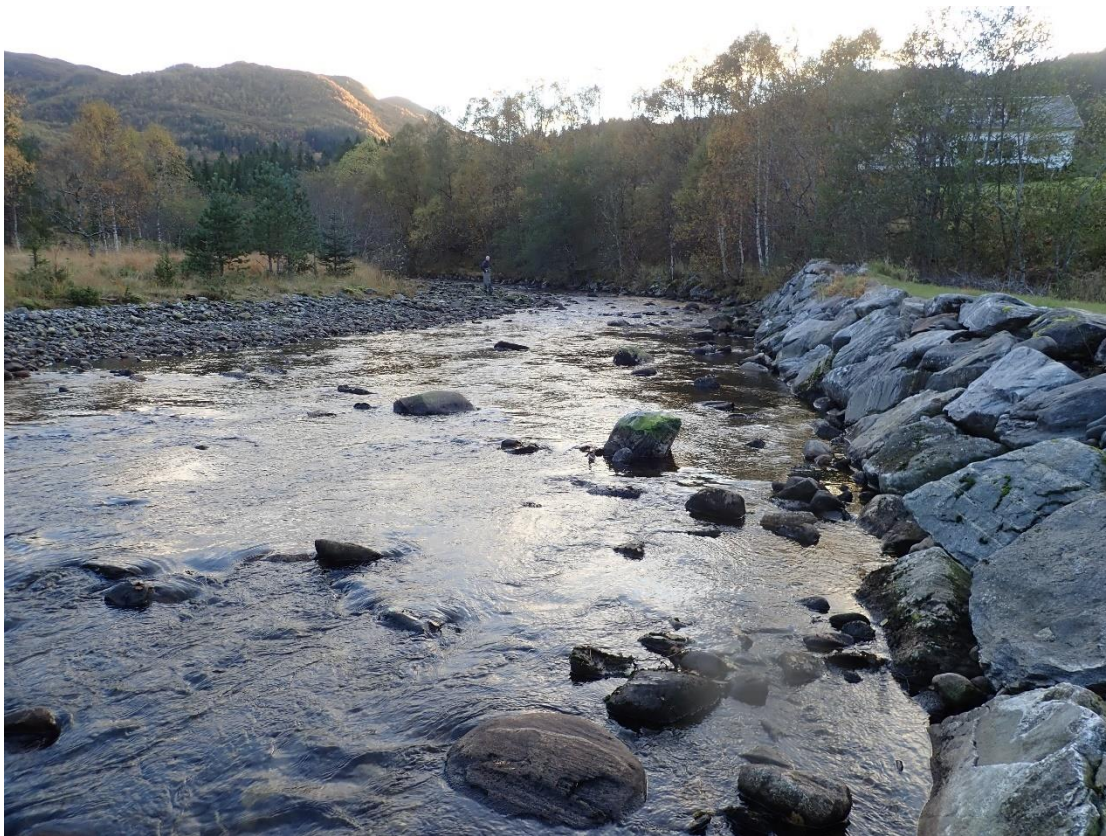
Figur 12 Åheimselva - erosjonssikring ved Hellebust
