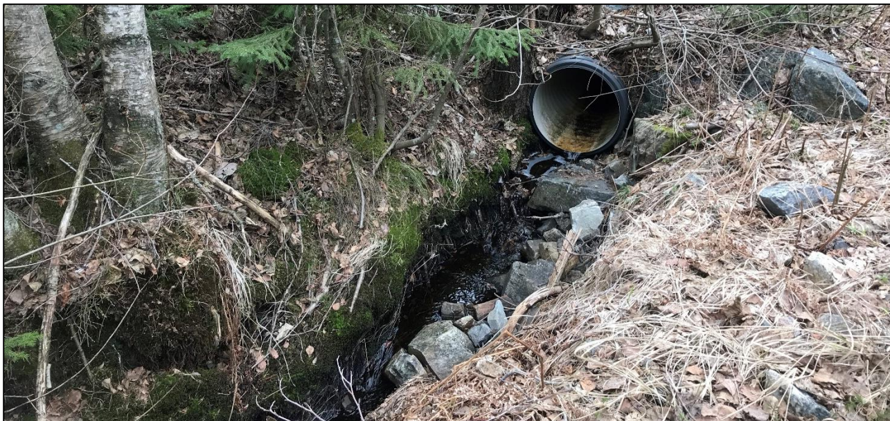
Figur 3-1. Deler av strekningen i øvre del av bekken er allerede rørlagt.
