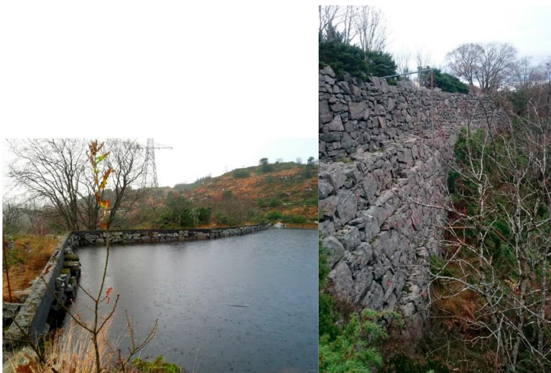
Figur 2: t.v oppstrøms side av hoveddam og sidedam (før etablering av ny terskel). T.h hoveddammen sett fra nedstrøms side. Bildene er hentet fra søknad.
