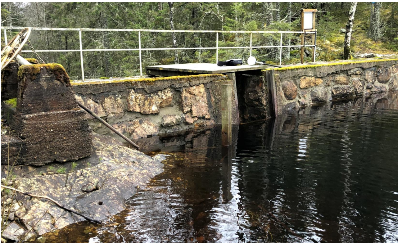
Dam Risen, oppstrøms side.
