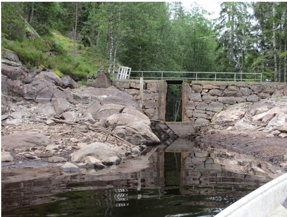
Dam Risen sett fra oppstrøms side, vannstand antatt samme høyde som omsøkt nivå.
