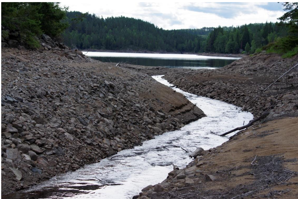
Damvannsundet sett mot Damvann, vannstand i magasinet antatt samme høyde som omsøkt nivå.
