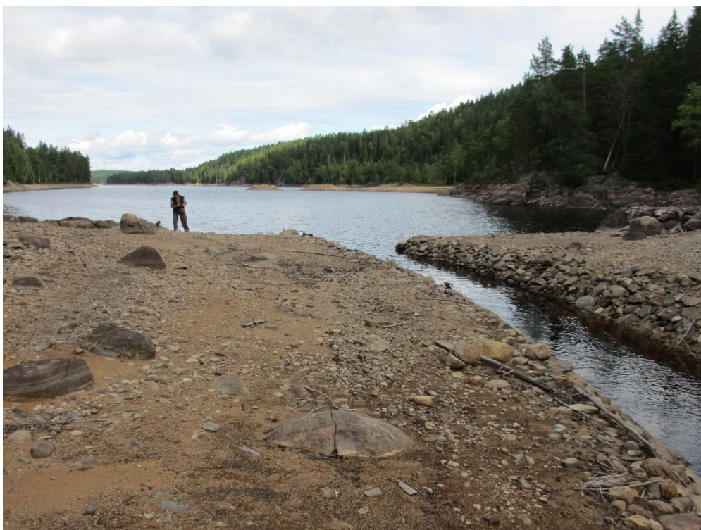
Damvannsundet sett mot Store Risen. Vannstand i Store Risen vil variere avhengig av tilsig og vannføring i kanalen.
