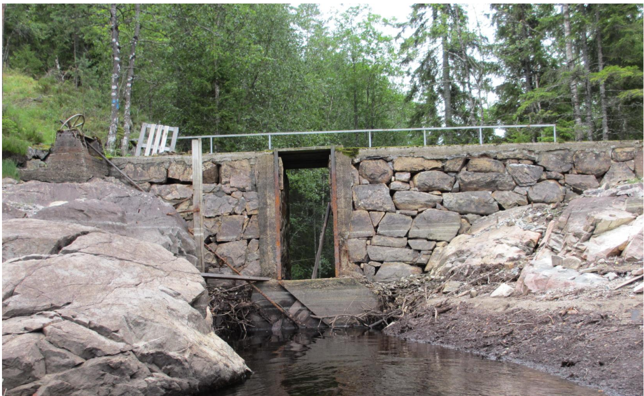
Figur 3. Dam Risen sett fra oppstrøms side. Bildet er tatt med senket magasin, rett før rehabilitering i 2012. Vannstanden på bildet er estimert til ca. kt. 189,6 (lokale høyder), tilsvarende som etter delvis nedleggelse.
