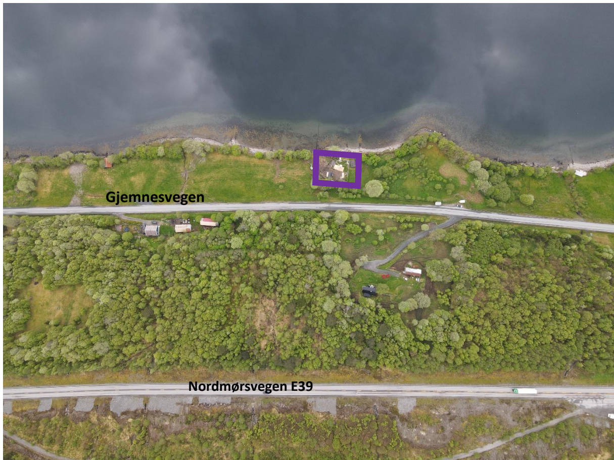
Figur 1: Dronefoto over kartleggingsområdet og nedre del av påvirkningsområdet. Kartleggingsområdet markert med lilla polygon. Utglidninger i løsmasseskjæringer er synlig som grå firkanter langs E39.
