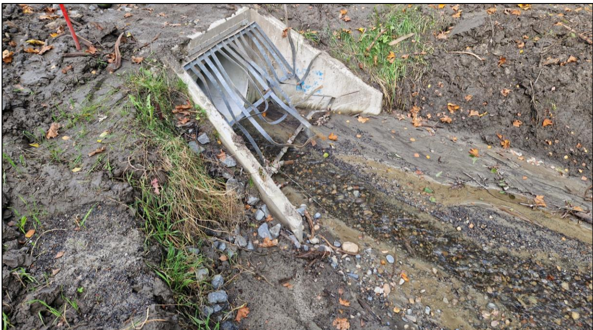
Figur 7 – Innløp til overvannsledning fra ravinen (23.09.2024)
