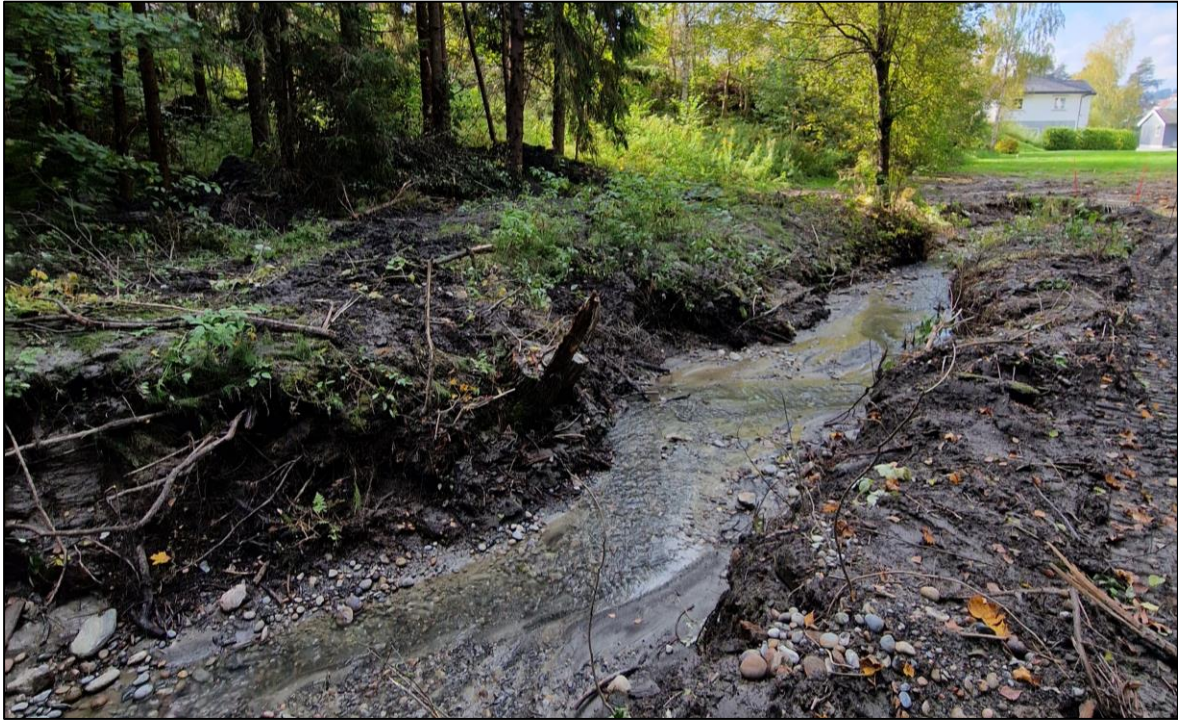
Figur 8 – Overgang fra bekk i ravine til overvannsinntak (23.09.2024)
