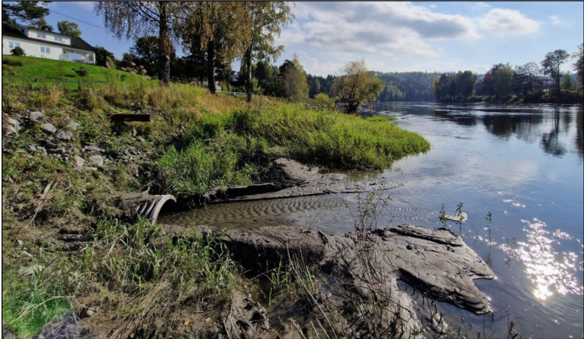
Figur 6 – Utløp av overvannsledning ut i Storelva (23.09.2024)
