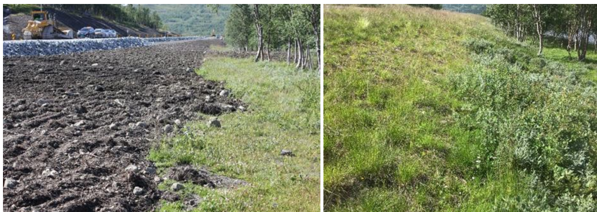
Figur 7. Revegetering med bruk av stedegne masser før og etter. Legg merke til hvor luftig massene er lagt på, og hvor flytende overgangen fra eksisterende vegetasjon her har blitt. Foto hentet fra Skrindo og Mehlhoop (2021).
