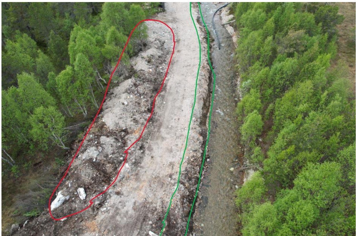
Figur 11. Anleggsvei lang kanalen mellom dammen og Litjevatnet.
