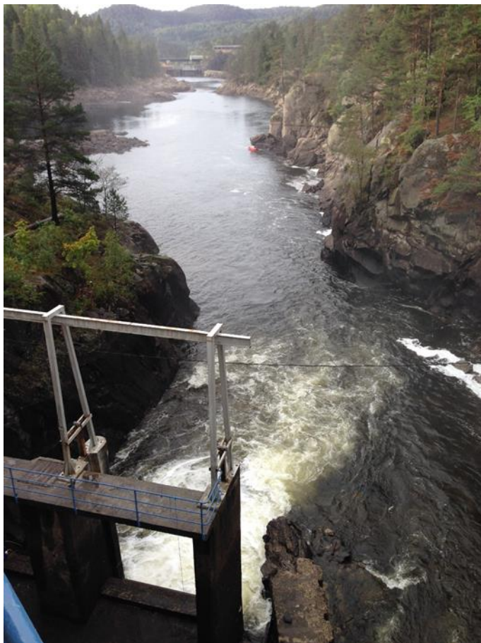
Figur 2: Nedtappet i forbindelse med arbeider i 2014. Bildet er tatt fra dam Langfos mot dam Vafos.
