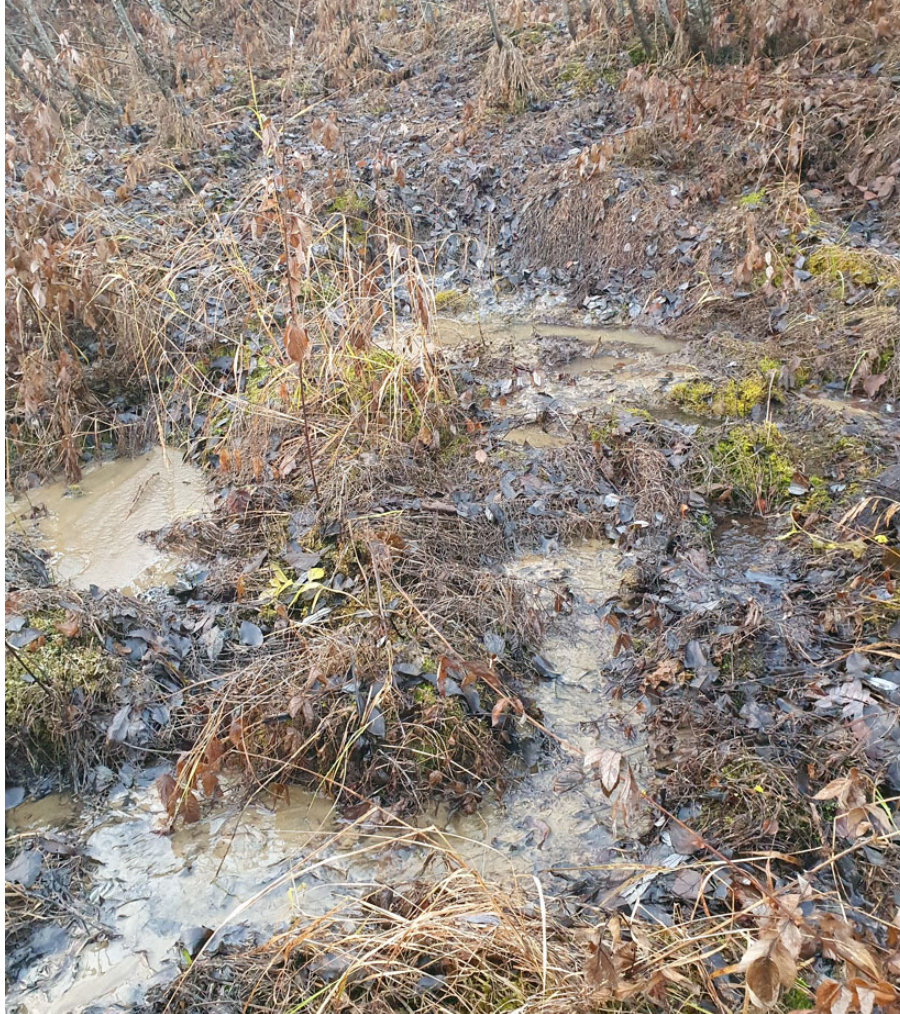
Figur 8: Bilde fra NVE [8]– viser vannstrømning fra grunnen i bunn av skråningen ned mot Sørkjosveien, mellom de to ravinene.
