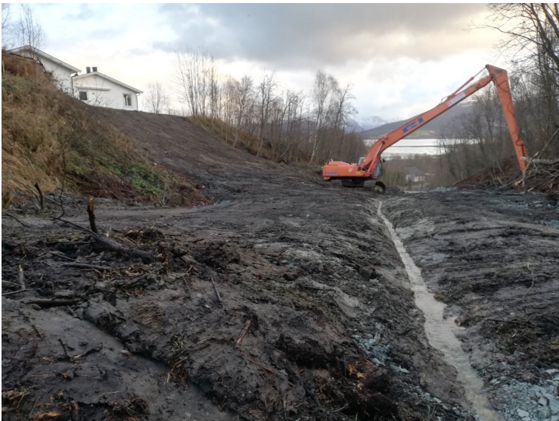
Figur 7: Bilde av nesten ferdig sikringstiltak i den sørlige ravinen (Multiconsult 03.11.2020)
