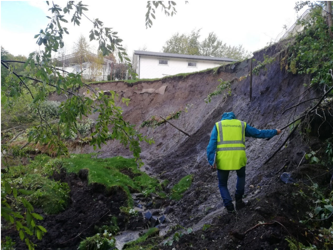
Figur 6: Bilde av skredet som gikk høsten 2020 (Multiconsult 22.09.2020)
