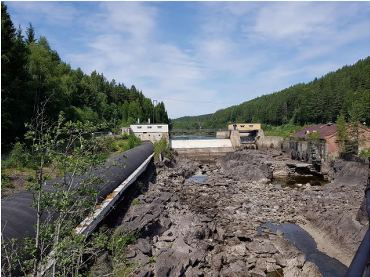
Figur 2.1 Inntaksdam og tørt elveløp slik det er mesteparten av året. Bunnsstrat av grov stein, blokk og bart fjell bærer preg av store vannhastigheter i flomperioder.
