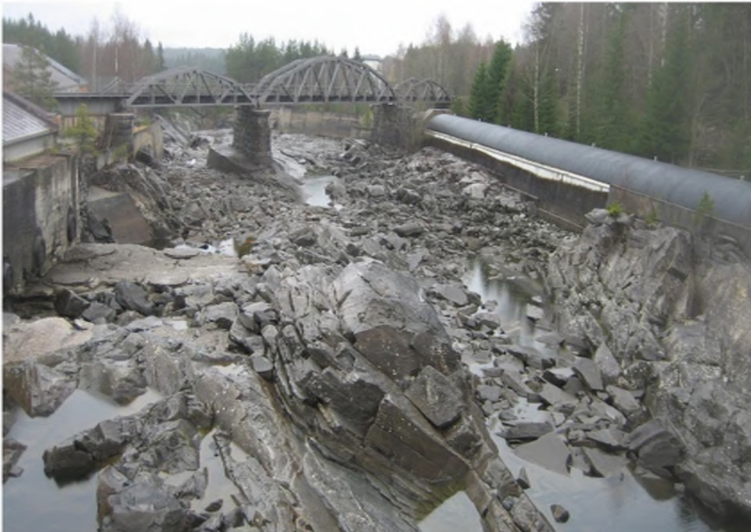
Figur 2.2. Elveløpet nedstrøms Hensfoss dam. Grov stein og blokk og bart fjell dominerer. Nedenfor togbroa er det bare bart fjell i elvebunnen. Bildet er tatt 23. april 2012.
