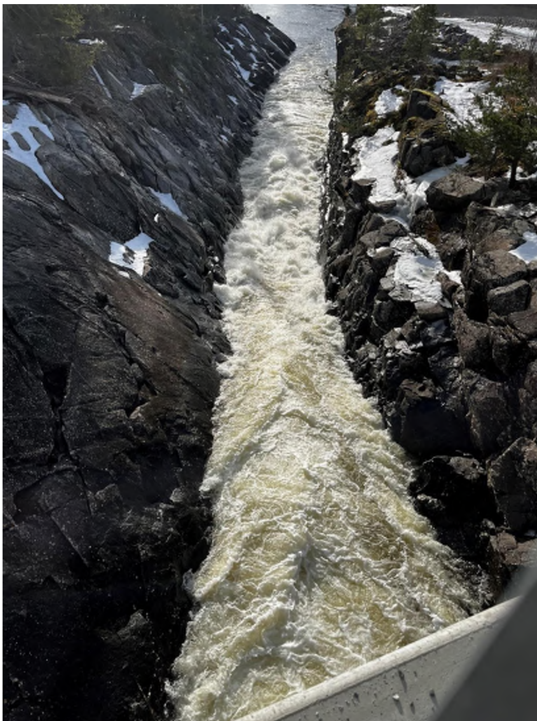
Figur 2.6. Elveløpet sett fra Bilbrua og ned til undervannet for Hensfoss kraftstasjon. Dette er en smal og bratt kanalignende strekning med stor vannhastighet og med bart fell som substrat. Foto 06.03.2025
