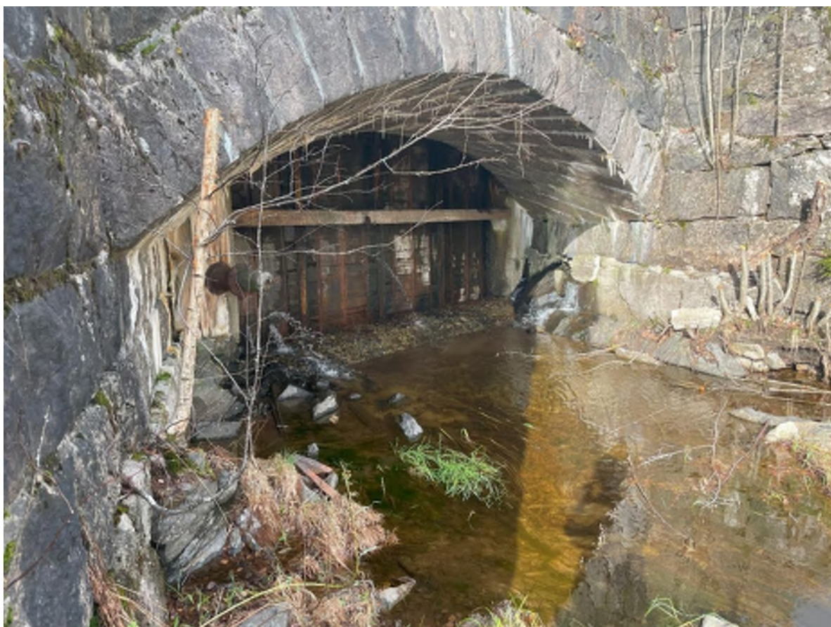
Figur 2.7 Lekkasjebekken har sitt utspring ved en gjentattet åpning i dammen til Hensfoss kraftstasjon. Det er liten men stabil vannføring som danner grunnlag for at bekken eksisterer.
