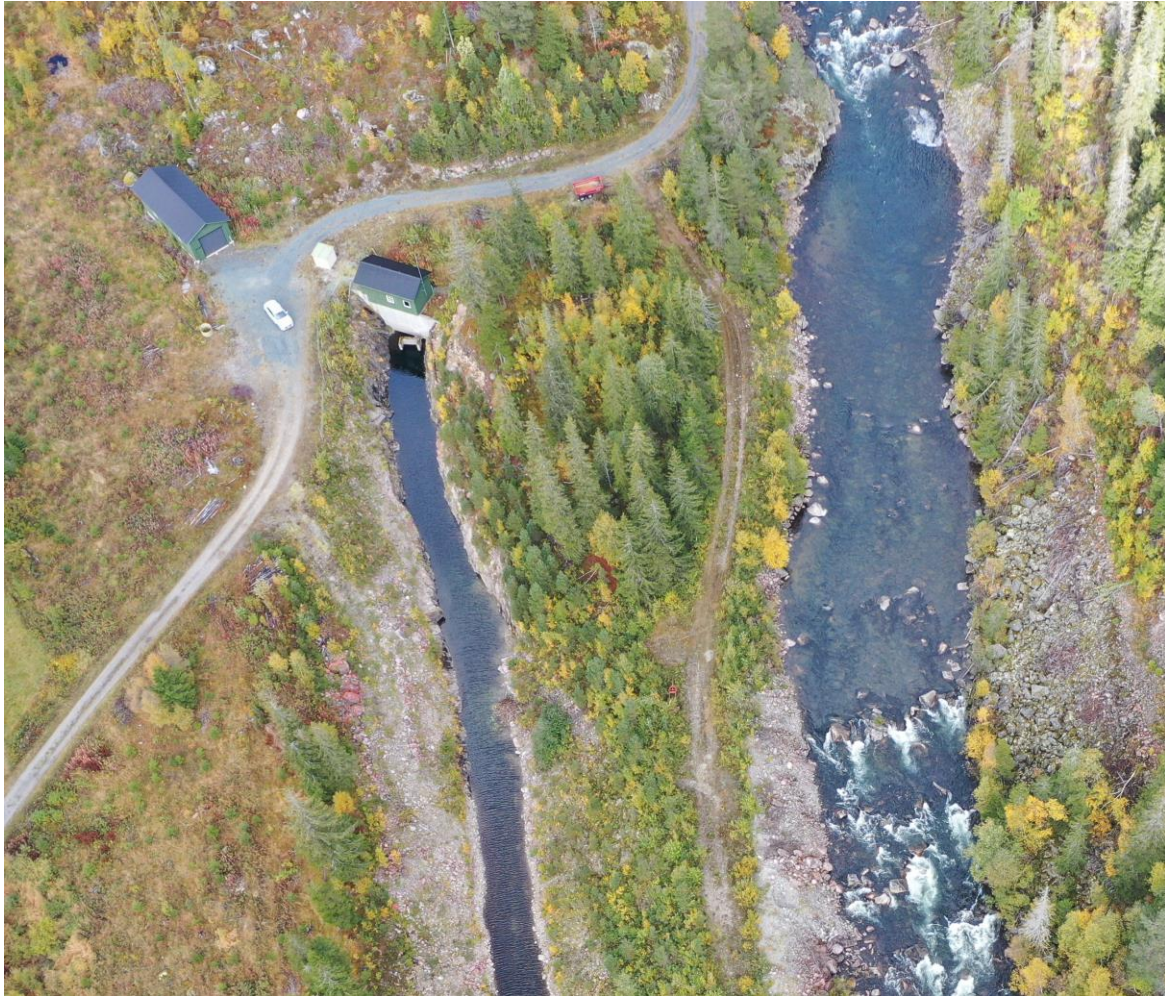
Bilde 4. Dronefoto av stasjonsområdet med avløpskanal, tilkomstveg og lagerbygg.
