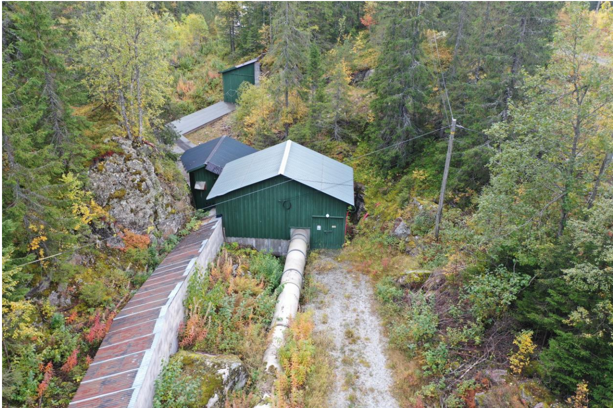
Bilde 4. Trykkrøyra mot Smørklepp I kraftverk frå 1922 (til høgre) og 1986 (til venstre) Kulvert mot tunnel som fører til Smørklepp II kan skimtast i bakgrunnen.
