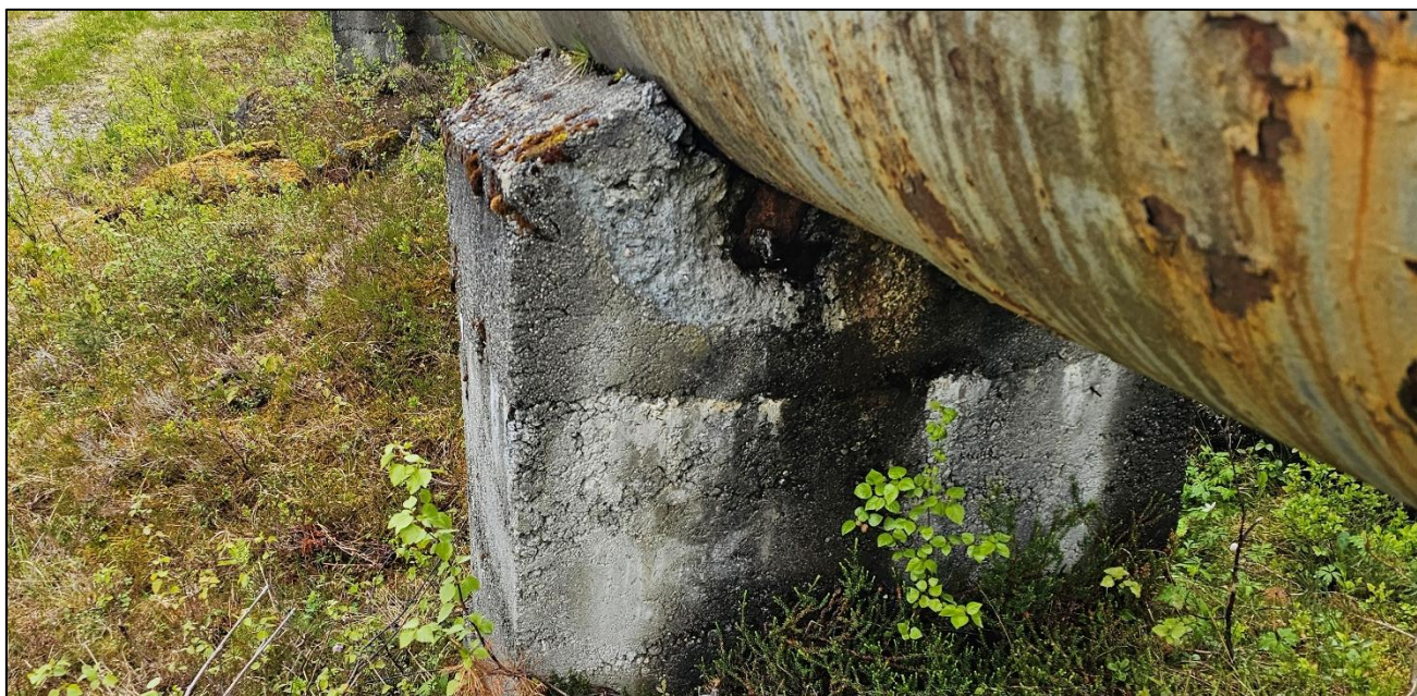
Figur 3-23: Eksisterende betongfundament. Bildet tatt på befaringsmai 2025.
