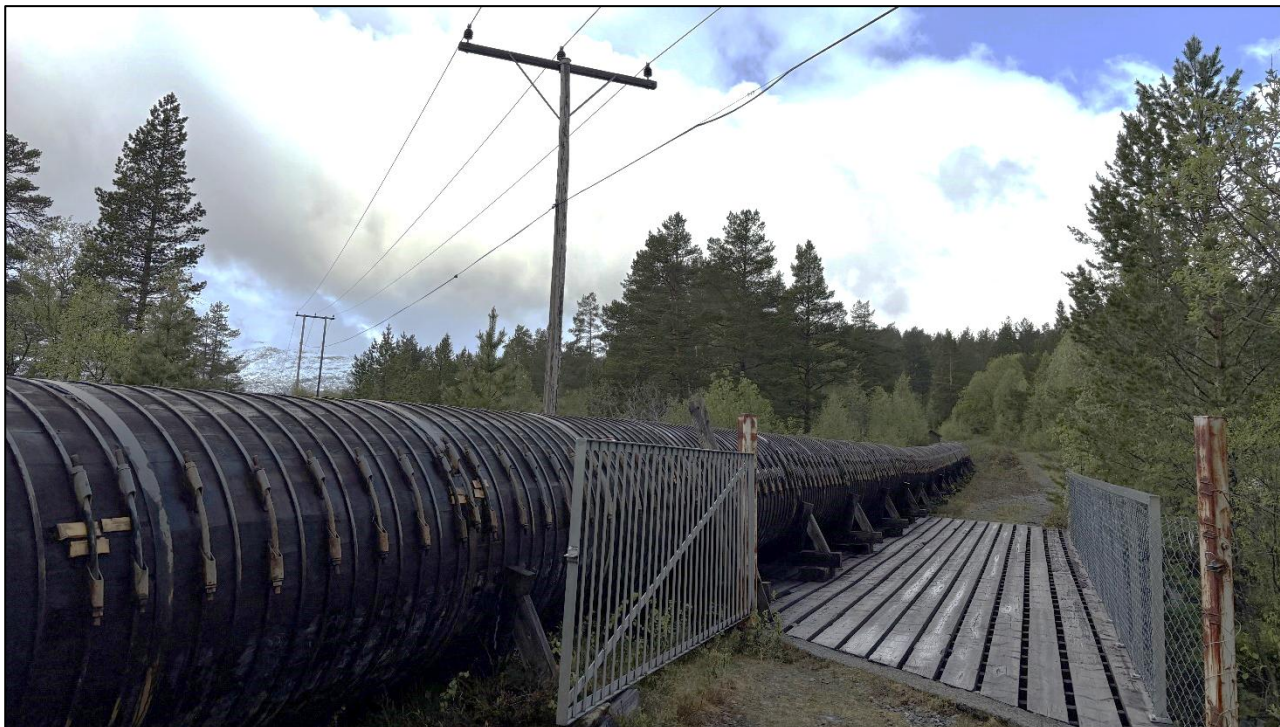
Figur 3-27: Dagens bru. Bildet tatt på befaring mai 2025.
