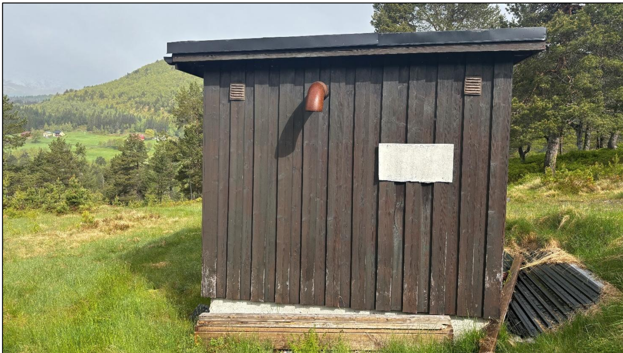
Figur 3-26: Eksisterende ventilhus. Bildet tatt på befaring mai 2025.
