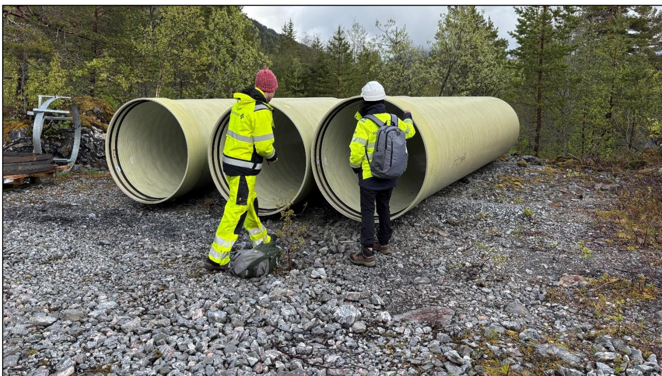
Figur 3-10: Eksisterende rør til lagring.
