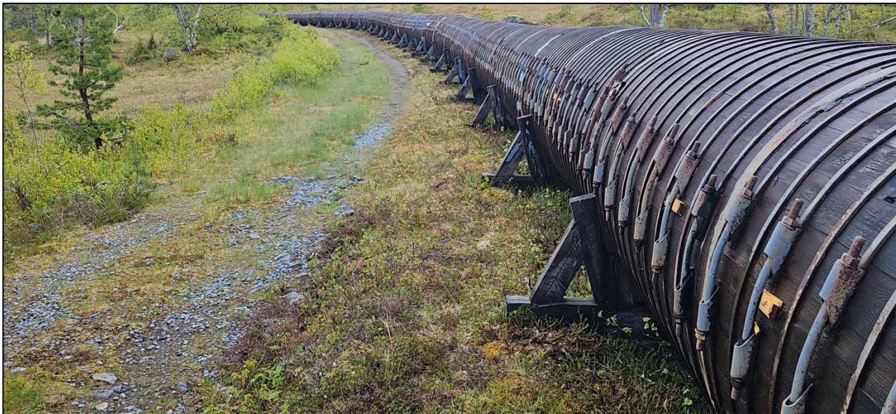
Figur 3-22: Eksisterende rørgate. Bildet tatt på befaringsmai 2025.
