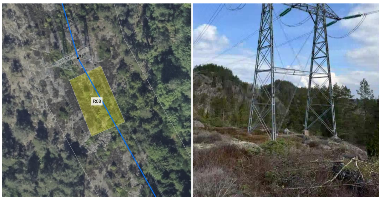
Figur 5-40 Ortofoto og oversiktsbilde over tiltaksområde ved R08. Bildet til høyre er tatt mot mast HT81. Foto: Statnett SF
