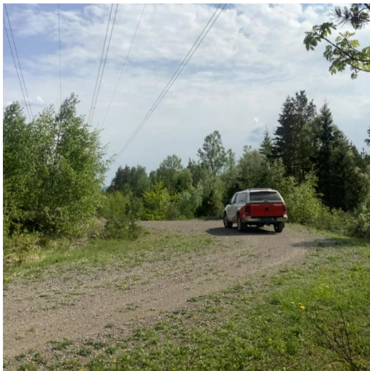
Figur 5-31 Oversiktsbilde over opparbeidet areal langs adkomstvei ved punkt R03B. Foto: Statnett SF
