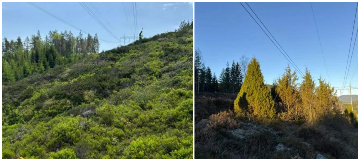
Figur 5-15 Oversiktsbilder over terrenget mellom mast 16 og 17 Hof-Tveiten. Tiltaksområdet for T105B. Foto: Statnett SF
