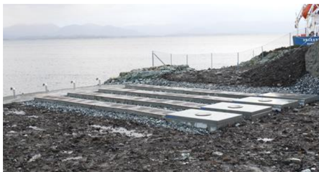
Figur 7: Dagens muffeanlegg (v) og kulverter for strekkavlastning ved fjorden (h) ved Mongstad. Nytt anlegg vil gi to ekstra muffe per område i tillegg til de fire eksisterende, samt to ekstra kulverter mot fjorden. Områdene vil gjerdes inn av sikkerhetshensyn.
