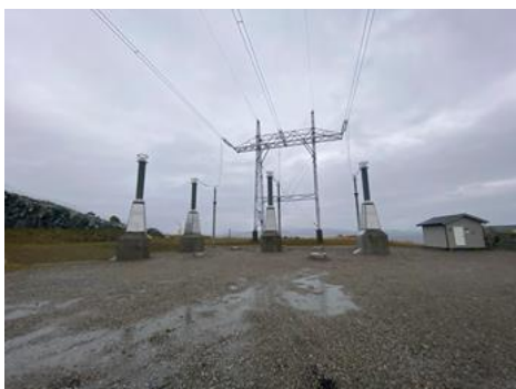
Figur 7: Dagens muffeanlegg (v) og kulverter for strekkavlastning ved fjorden (h) ved Mongstad. Nytt anlegg vil gi to ekstra muffe per område i tillegg til de fire eksisterende, samt to ekstra kulverter mot fjorden. Områdene vil gjerdes inn av sikkerhetshensyn.
