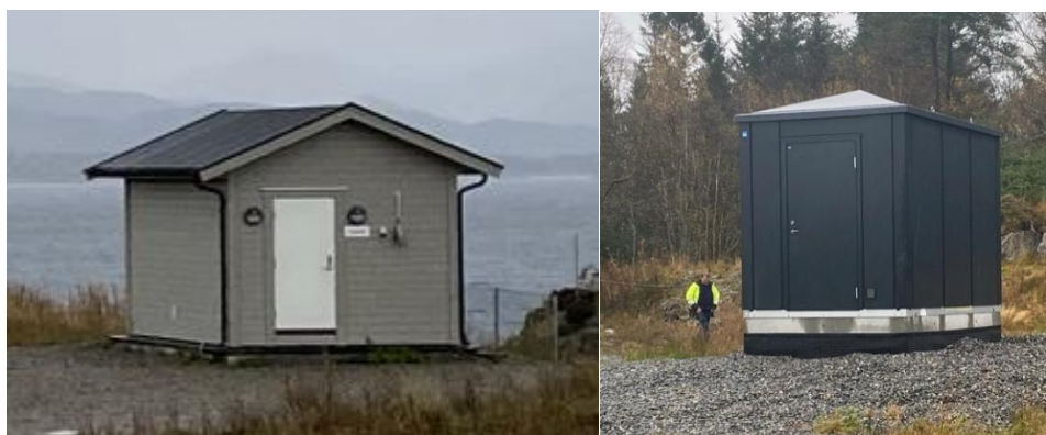
Figur 6: Kontrollhus, Eksisterende (v) og planlagt ny standard (h)
