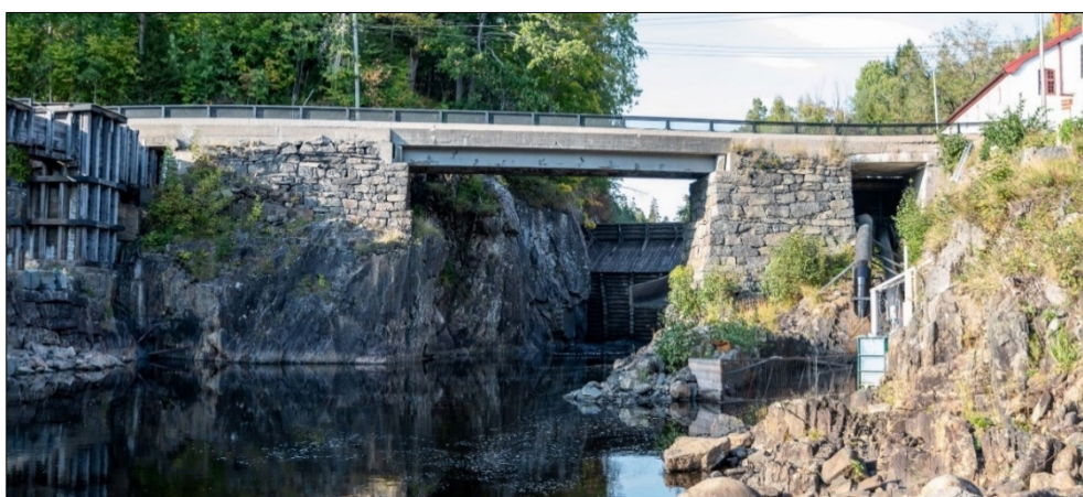
STASJONSTOMT. Hammerfossen kraftstasjonen og fisketrapp skal bygges til høyre i bildet. Lysmaskinen benytter den vertikale sumpen til venstre i bildet. Foto: Frode Kroglund.
