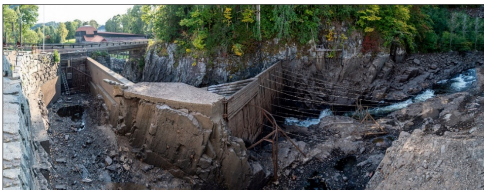
HAMMERDAMMEN. Bildet viser Hammerdammen med åpen bunnluke. Inntaket til Hammerfossen kraftverk skal etableres i sidekanalen til venstre i bildet. Lysmaskinen skal benytte tunnelen som er etablert i 1803 på motsatt side av elva. Foto: Frode Kroglund.
