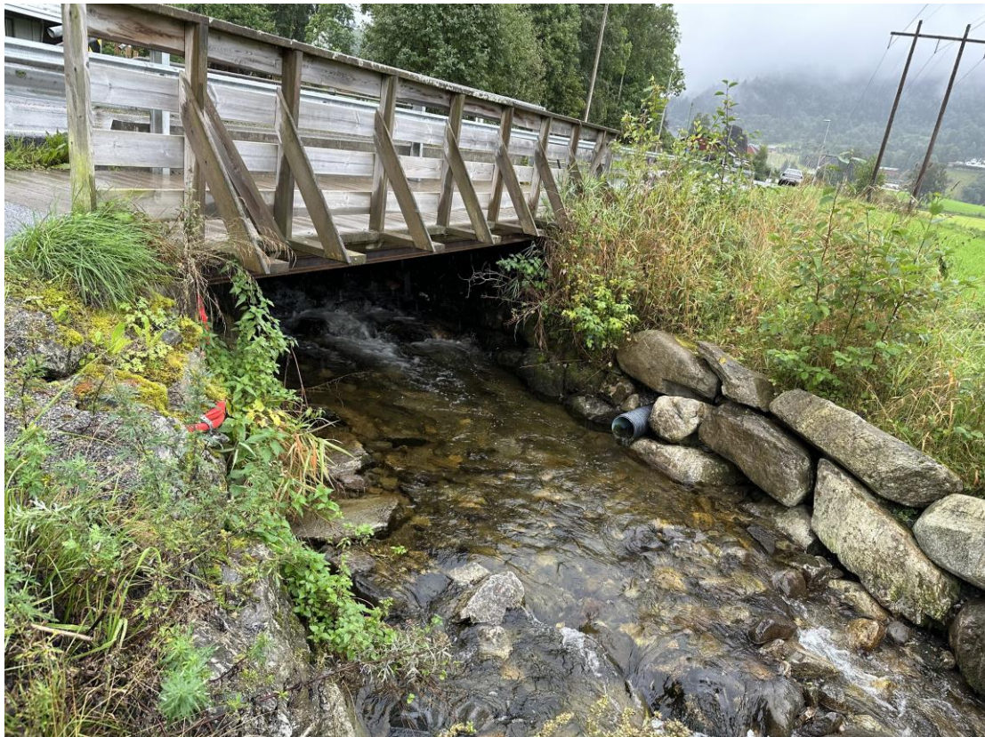
Figur 4: Dagens vei- og gangbru over Vetlaelvi (Vetlabrui).
