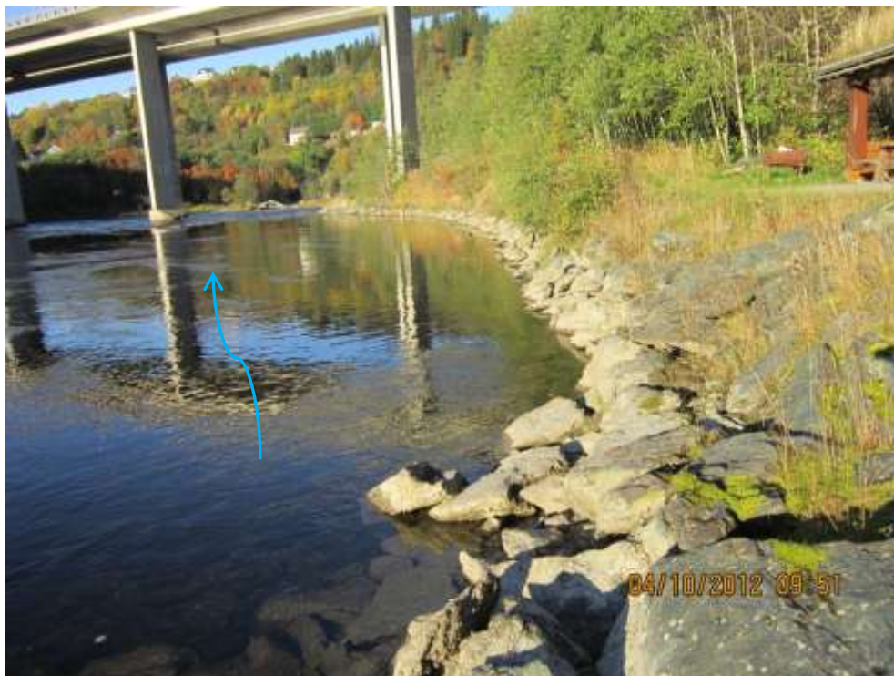
Bilde 1: Sikring i god stand lengst nedstrøms i Nidarvoll sonen.
