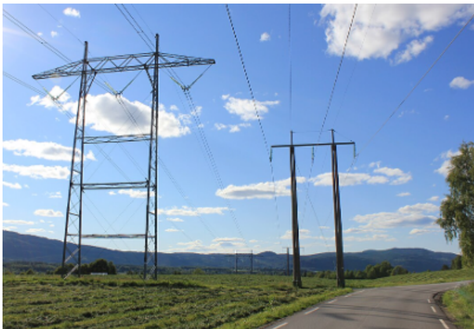
Figur 15: 420 kV sentralnettslinje og 132 kV regionalnettslinje i parallell.
