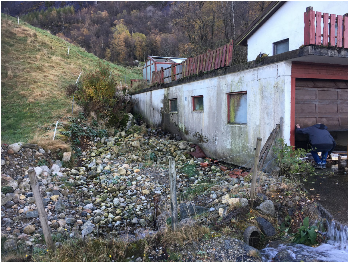
Fig. 10: Kraftstasjon bygges til venstre for fraflyttet bygning
