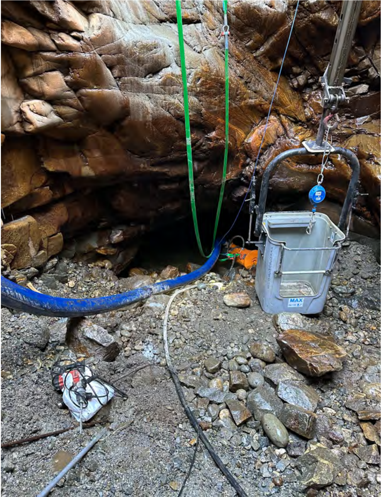
Foto: Etter oppstart fjerning av masser.
