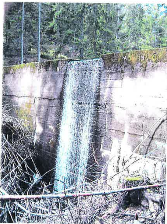
Bilde 1: Fladbydammens overløp til bekk.
