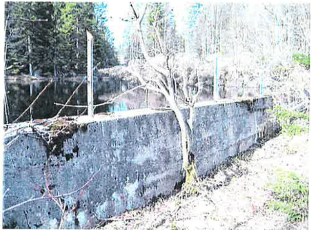
Bilde 4. Detalj fra Askdammen øvre
