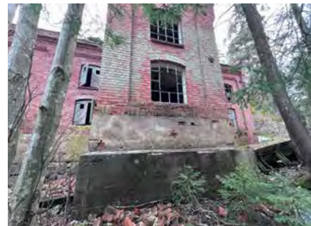
Tørkeriet: Utbygg på fasade sør-øst.
