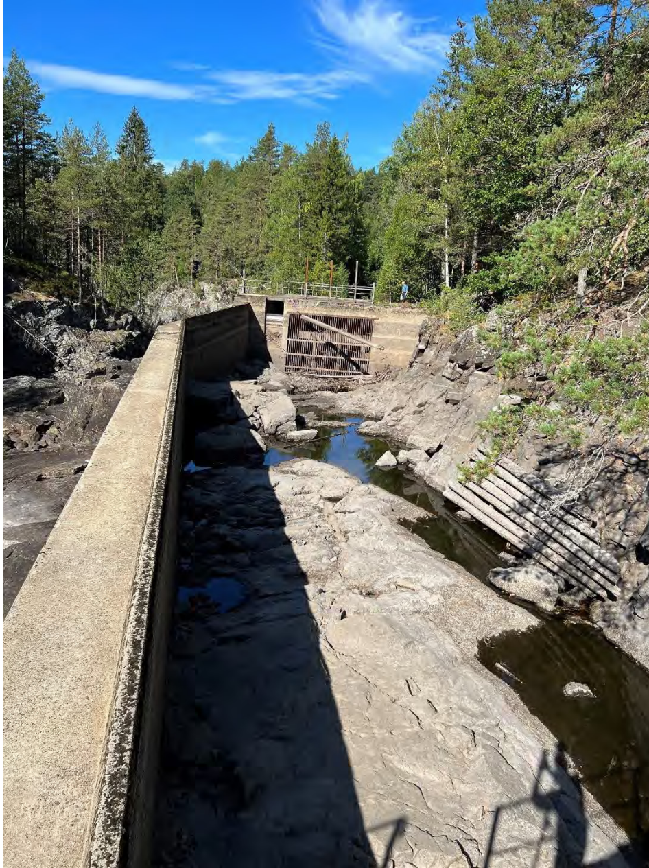
Figur 7 Bilete inntaksområdet teke frå oppstraums side. Betongkant på toppen av kanalveggen blir forsterka og kanal vert utvida på fjellsida.
