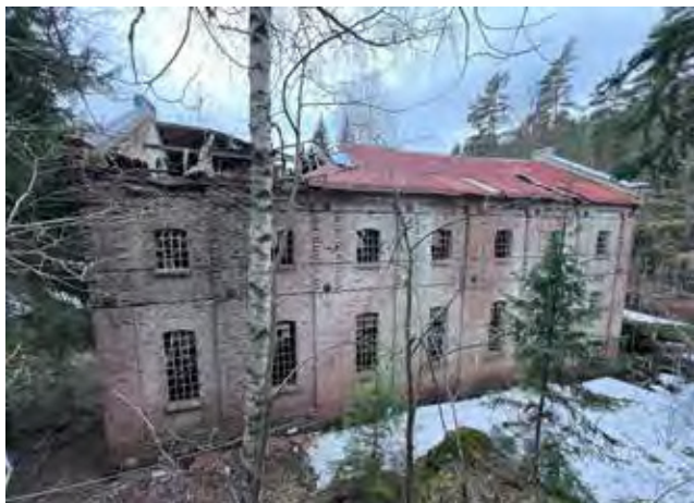
Sliperiet: Fasade nord-øst.
