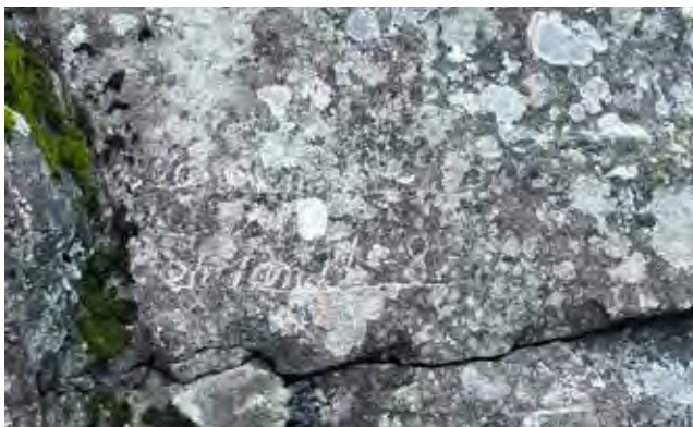
Inskripsjoner i fjellvegg med vannstandsmerker for flom.
