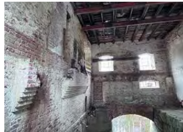
Sliperiet: Interiør 1. etg. Turbinrom.
