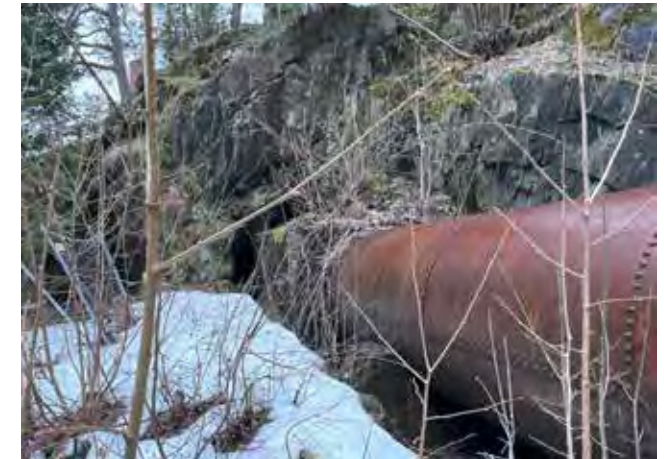
Rett før tørkehuset går turbinrøret inn i en kort tunnel.
