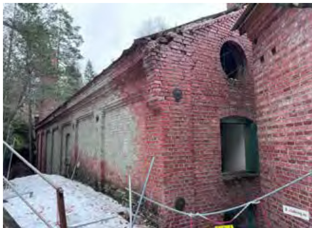
Tørkeriet: Fasade nord-vest.
