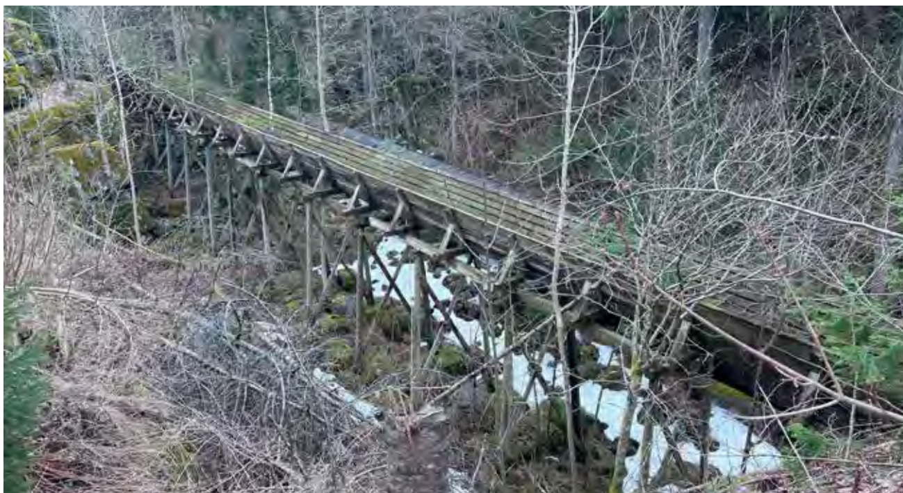
Tømmerrenne med turbinrøret i bakgrunnen. Sett mot øst.
