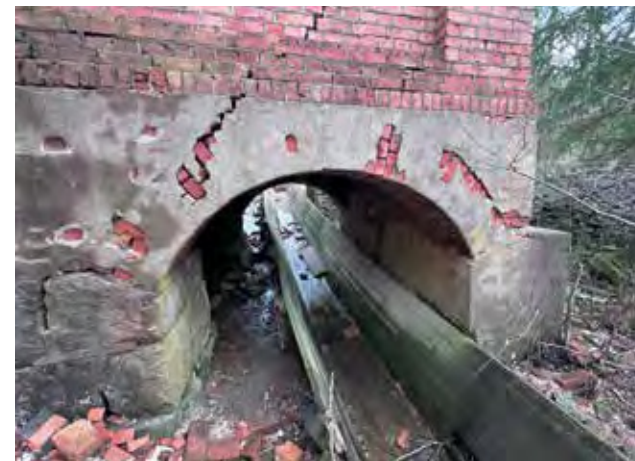
Tømmerrenna passerer under utbygget på tørkeriet.
