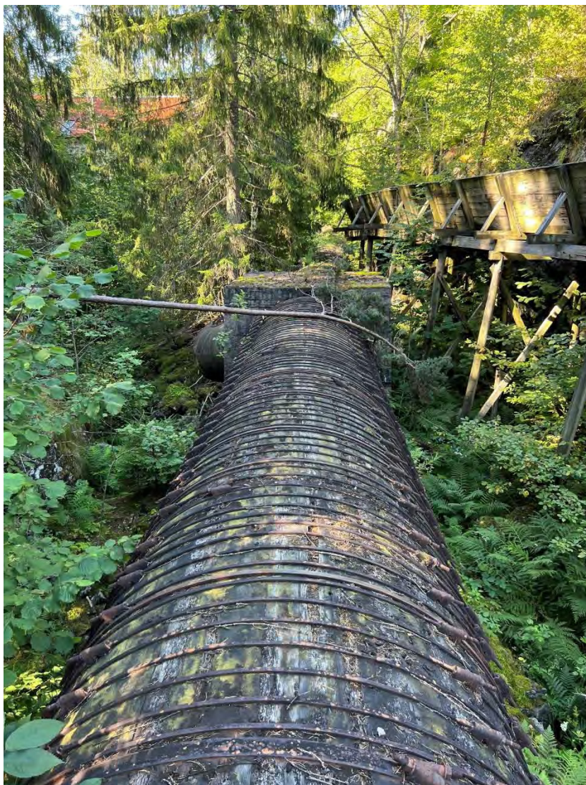
Figur 12 Eksisterande rør og restar av tømmerrenne vert rivne. I dette området vert nytt trykkør nedgrave og kraftstasjon bygd litt framme til venstre i bilete.
