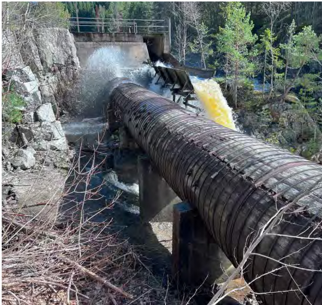
Dam med turbinrør og tømmerrenne. Ålekaret var plassert til venstre for damfoten.
