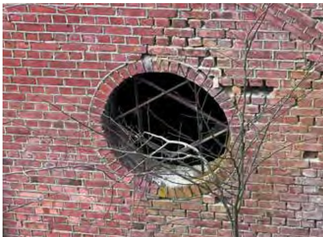
Tørkeriet: Detalj av vindu på gavlfasade nord-øst.
