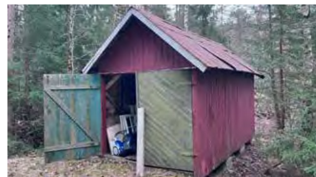
Garasje: Fasade nord mot Stifossveien.
