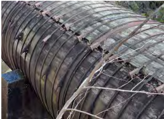
Store deler av turbinrøret er i tre.
