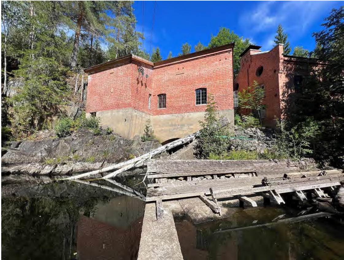
Figur 4. Eksisterande betongterskel vert gjenbrukt til å halde vassnivået i utløpskanalen. Utsparing vert etablert for å hindre laksefisk å strande på oppstrøms side brå stans i kraftstasjonen ved nettutfall. Vassstand på nedstrøms side er ca 10cm under terskel ved svært låg vassføring. Mindre differanse ved større vassføringar.
