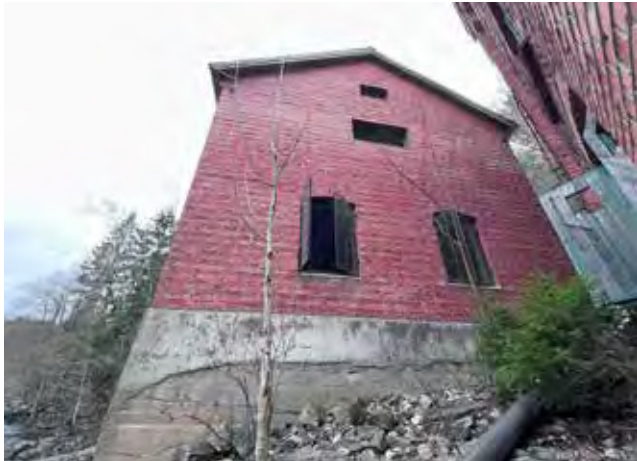
Kraftstasjonen, fasade øst.
