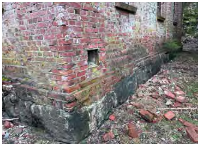
Sliperiet: Detalj fasade sør-øst.
