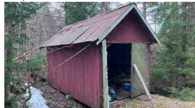
Garasje: Fasade nord mot Stifossveien.
