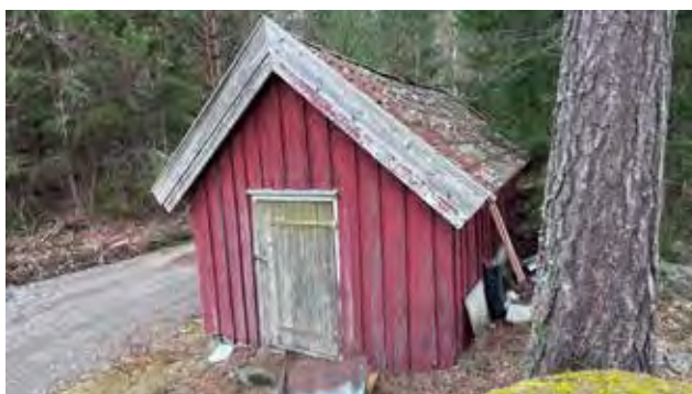
Bryggerhus: Fasade nord-øst.
