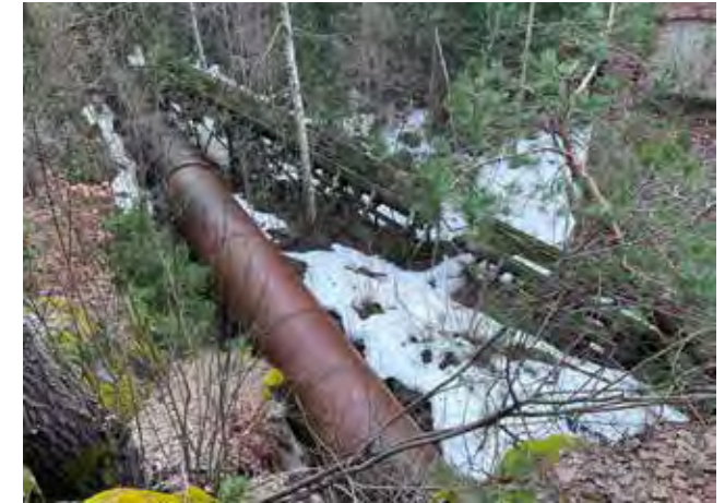
Turbinrør og tømmerrenne sett mot nord-øst.
