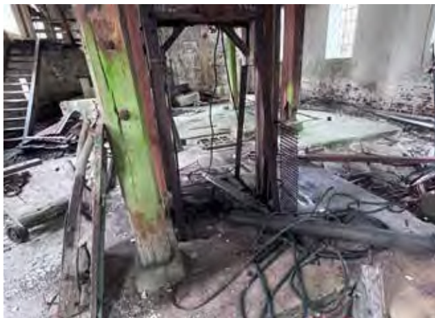
Sliperiet: Bevarte rester av heis mellom etasjene.
