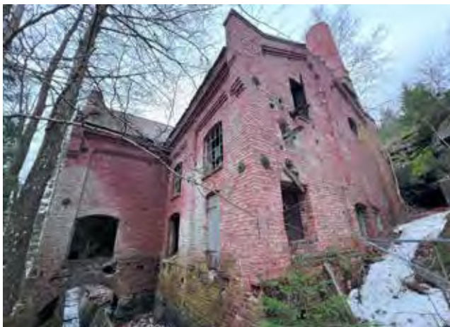
Tørkeriet: Fasade nord-øst.
