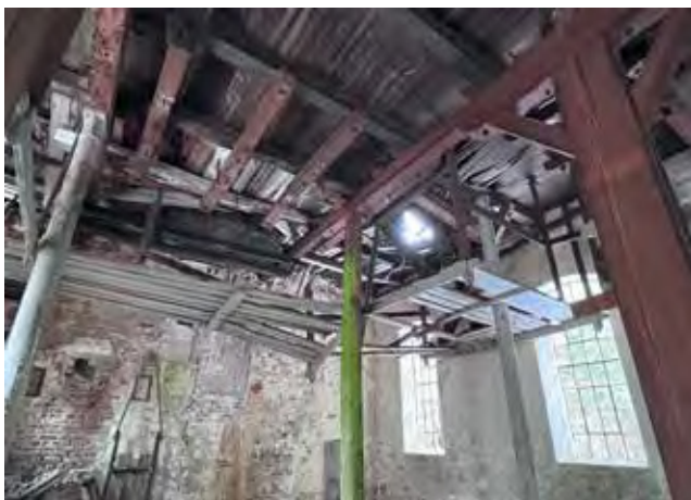
Sliperiet: Interiør 1. etg. sett mot nord.
