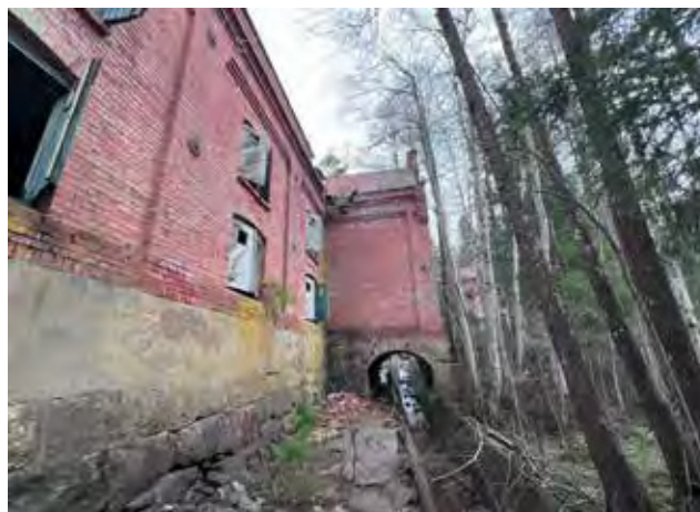
Tørkeriet: Fasade sør-øst. Tømmerrenna passerer under.
