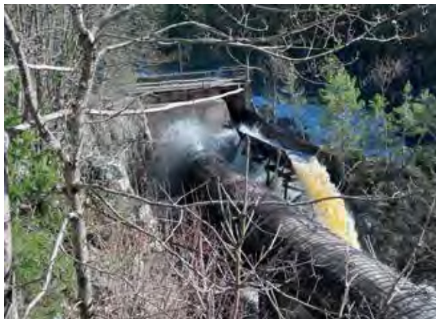
Dam med tømmerrenne og turbinrør.
