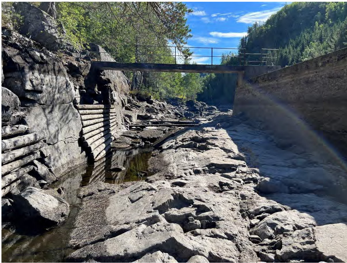
Figur 8 Nærbilete av kanal frå nedstraums side. Midlertidig betongvegg vert etablert rett oppstraums brua for vassavleiing ved bygging av inntak.
