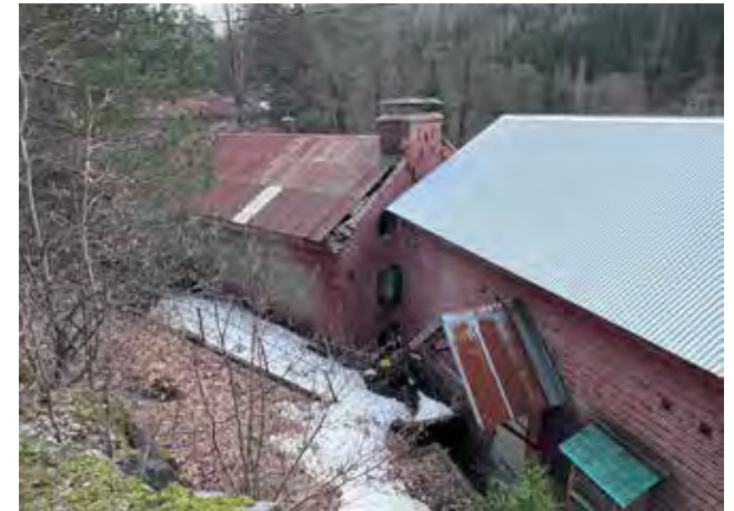
Kraftstasjonen: Fasade nord mot Stifossveien.
