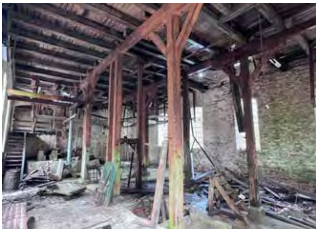
Sliperiet: Interiør 1. etg. sett mot nord.
