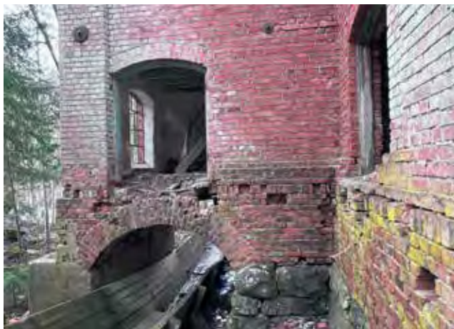
Tørkeriet: Detalj av tømmerrenne som går under utbygg.
