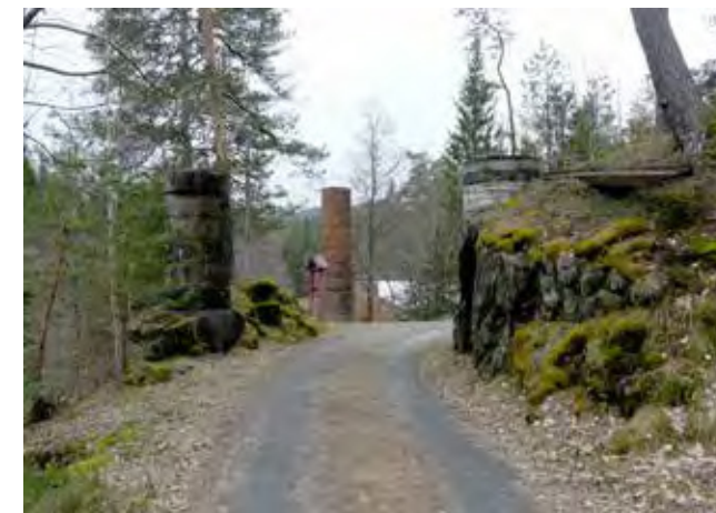
To søyler for kran laget av stablede slipesteiner. Tverrbjelke demontert, sees til høyre i bildet
