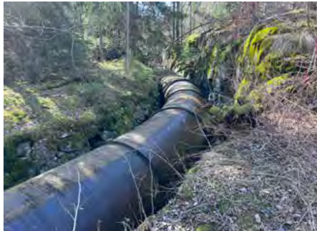
Første sving etter dammen. Her er benyttet stålrør.
