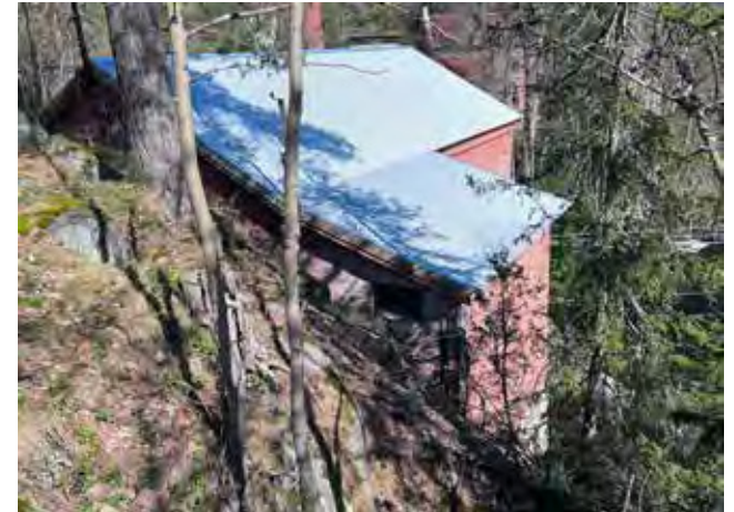
Kraftstasjonen: Fasade vest.
