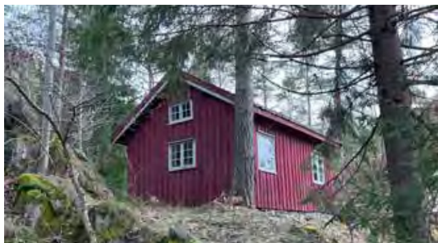
Snekkerbu: Sett mot nord.
