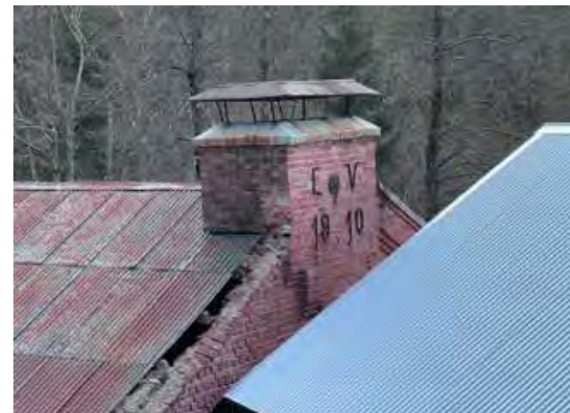
Tørkeriet. Luftepipe med årstall på gavl mot sør-vest.
