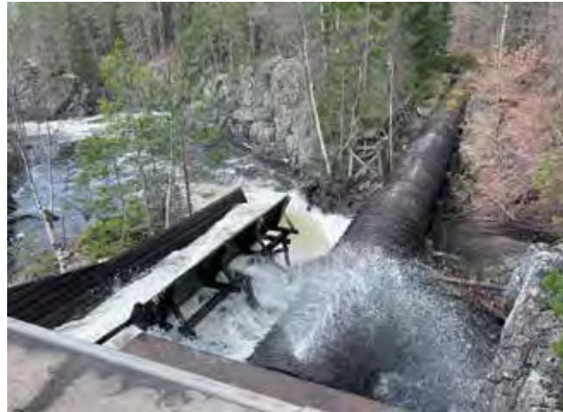
Turbinrør og tømmerrenne sett fra inntaksdammen.
