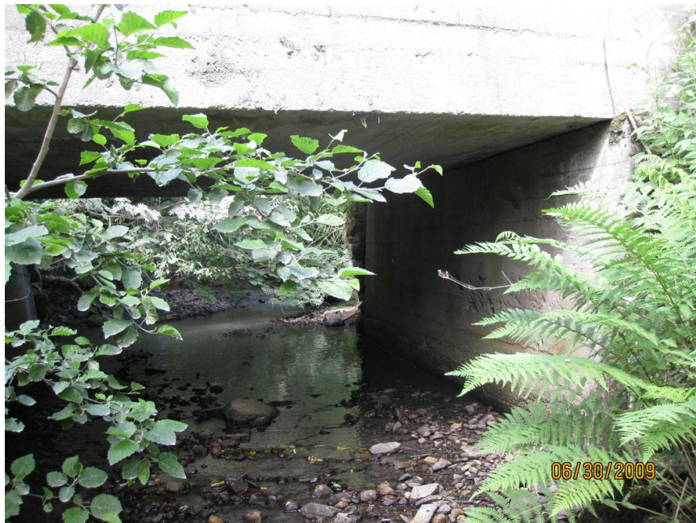
Bilde 1: Brua ved veien. Sikringsanlegget skal starte her.
