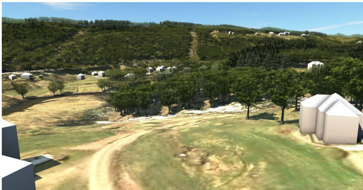
Figur 3-7. Skolandsveien 65 (t.v.) og 69 (t.h.). Oversiktsbilde som viser alternativ 2.0.3 som føres oppover dalsiden i horisonten. Traseen danner en kontrast til landskapet rundt. Bilde er hentet fra 3D-modell.
