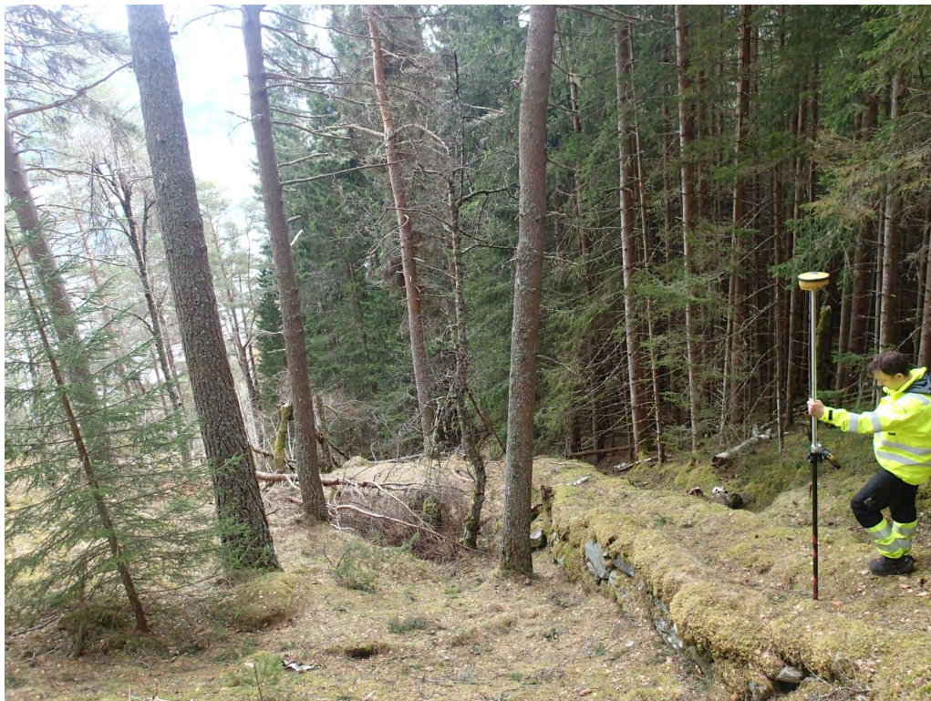
Figur 20 Bilete teke i nedre deler av trasèen. Her ligg den gamle røyrгата skjult i ein streinmur.
