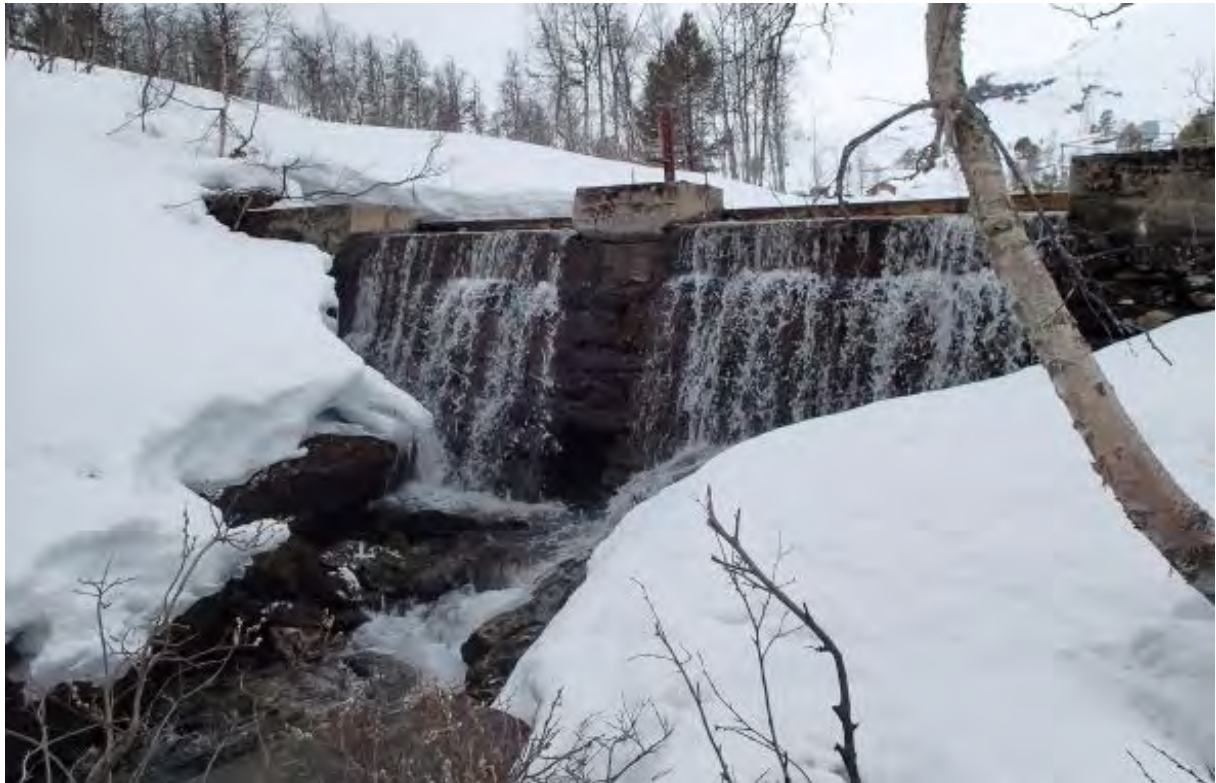
Figur 22 Døsjagrovi ved inntak, vassføring om lag 270l/s (10.05.17)
