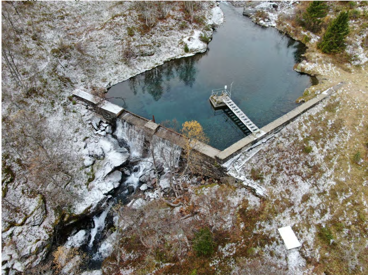
Figur 13 Eksisterende inntak før utbygging
