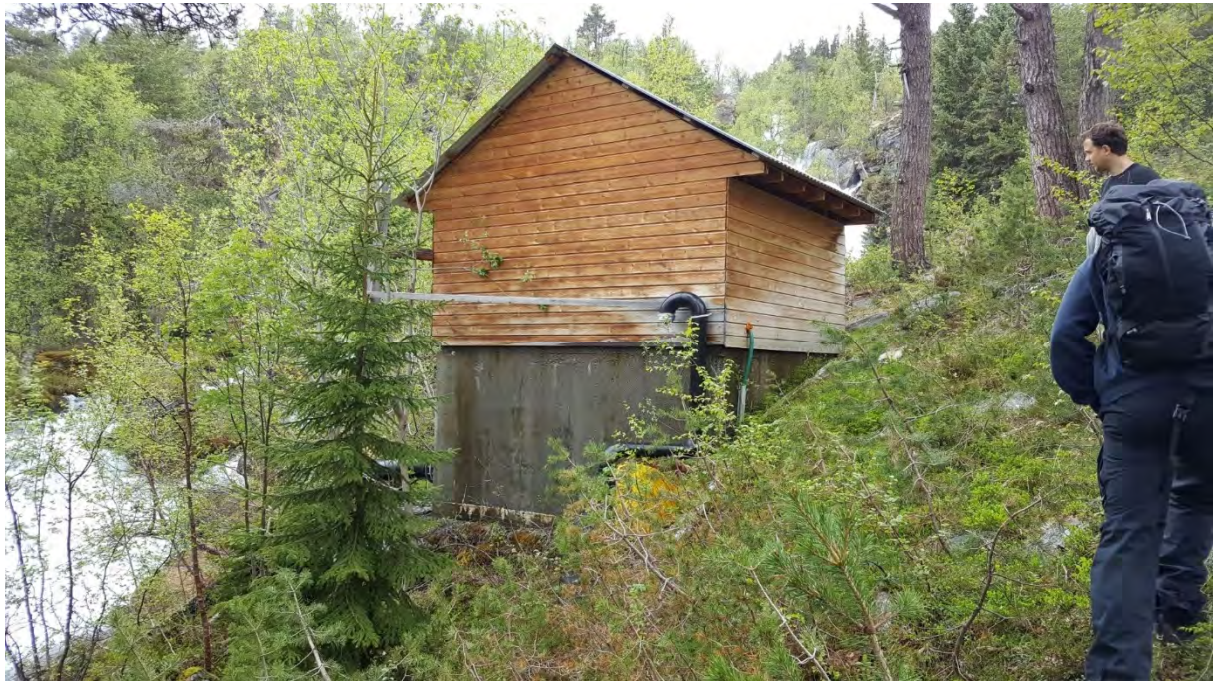
Figur 17 Bilete viser kraftstasjonsbygget for Harastølen II. stasjonen er ikkje lenger i drift.
