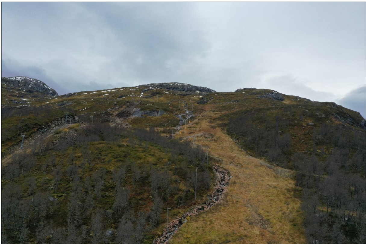
Figur 5: Bilete viser øvre del av påverknadsområdet og skitrekket. Fjellsida har ei generelt jamn helling opp til øvre del av påverknadsområdet. Bilete er tatt mot sør.
