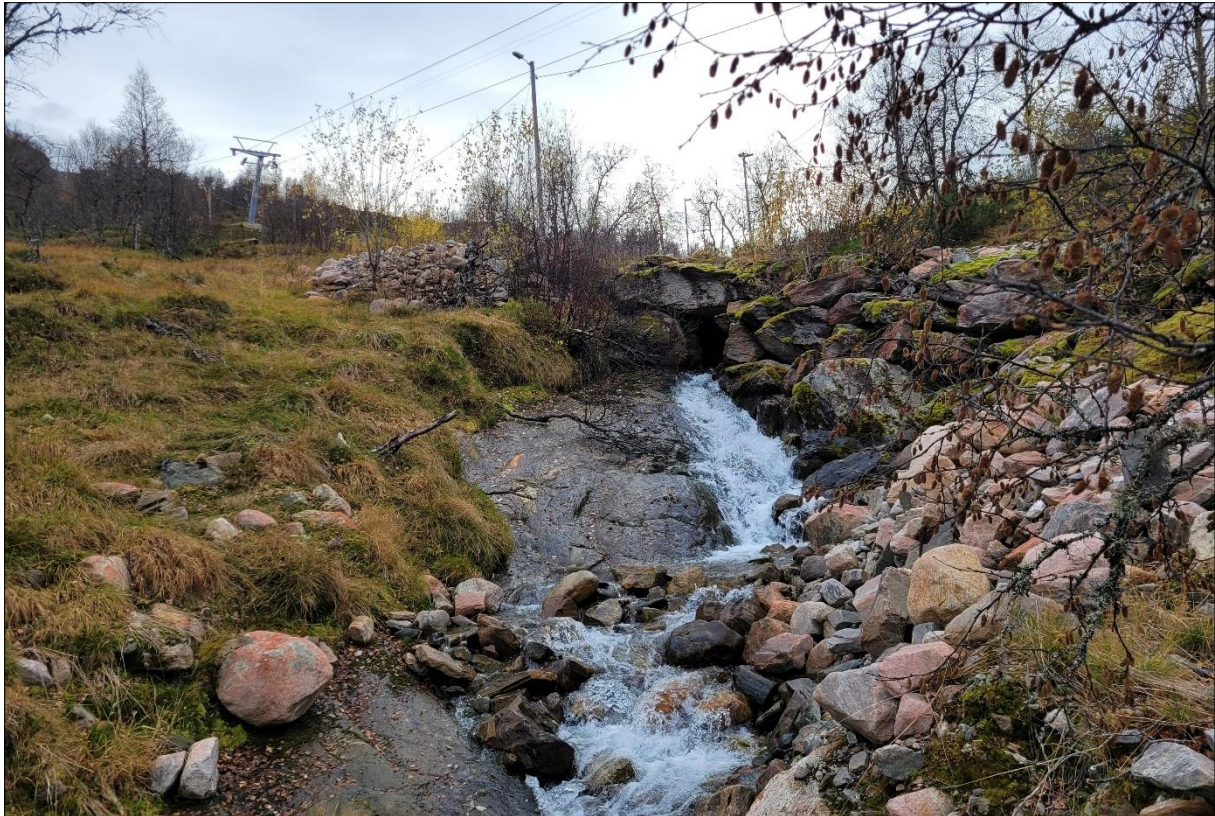
Figur 34: Kulverten under skitrekket, sør for kartleggingsområde 2, dannar eit kritisk punkt i elva. Oppstuvning ved kulverten er tolka å ha ført til at elva spora av som resulterte i flaumskredavsetjingane ved infopunkt 7. Elva renn hovudsakleg på fast fjell.
