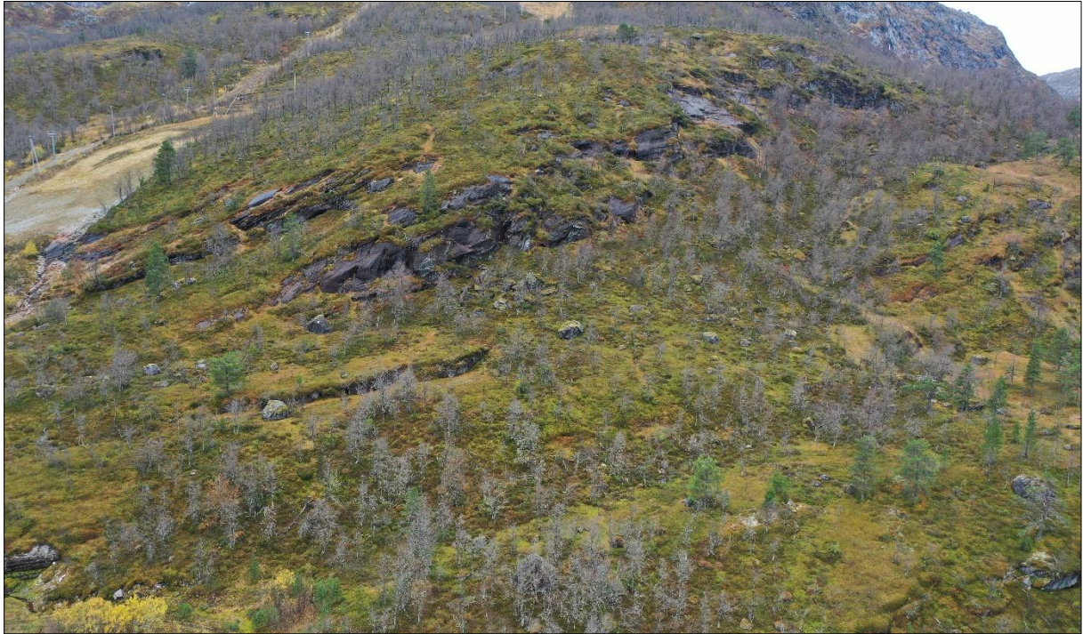
Figur 30: Fjellpartiet i påverknadsområdet sør for hyttefeltet (kartleggingsområde 1). Forutan om nokre overheng i nedre del av fjellet, er berggrunnen massiv. Terrenget nedanfor er generelt slakt, og fjellet har ei relativt jamn stigning. Infopunkt 6.
