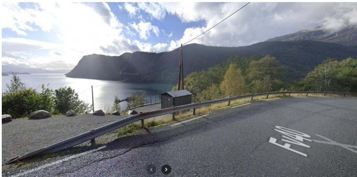
Bilde av eksisterende nettstasjon opp med fylkesveien, oppdrettsanlegget i bakgrunnen. Bilde er henta fra Google map.
