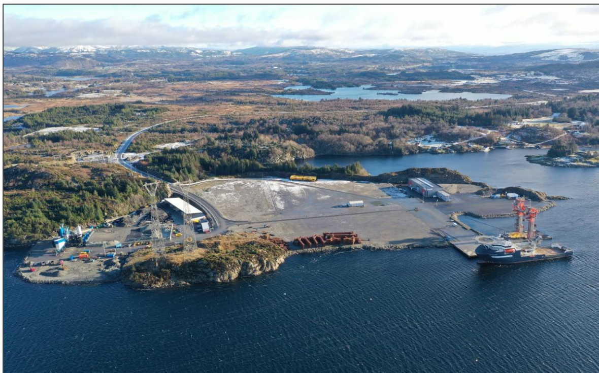
Figur 2-5. Flyfoto som viser Haugaland Næringspark. Kilde: Næringsforeningen Haugalandet.
