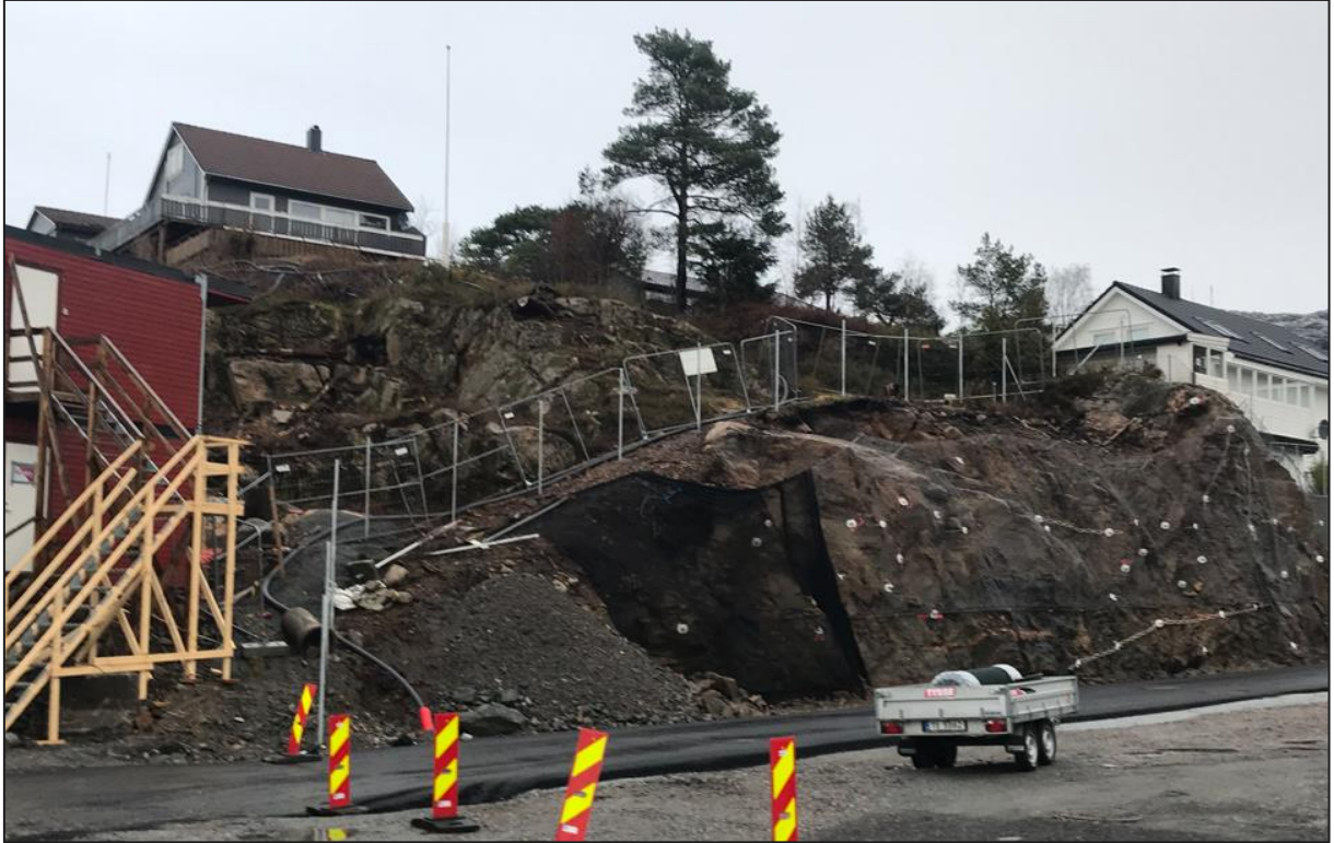
Figur 4-4: Bilde av bergskjæring fra sør av tomten. Mottatt fra kunden som IMG_9903. Dato ukjent.
