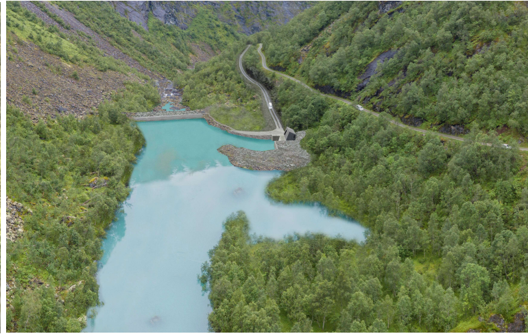
Dam og inntak Nyasetlii
