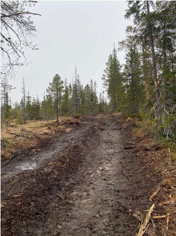
Bilder 2-8 Trase ned til kraftstasjon. Her var det tilfeldigvis etablert kjøreveg for hogstmaskiner nøyaktig der den planlagte vegen til stasjonen skal være
