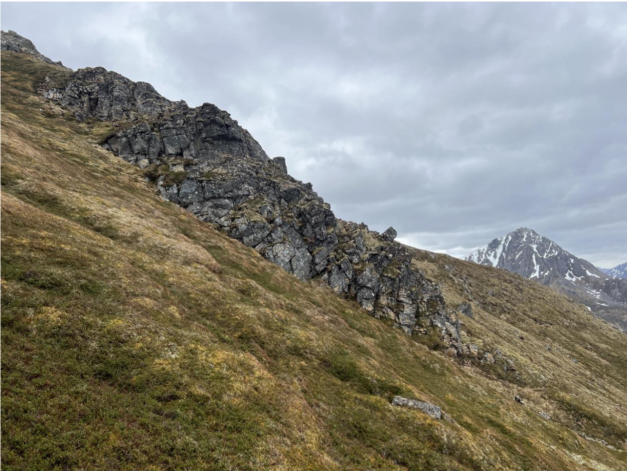
Figur 16: Løsneområder for steinsprang i øvre del av fjellsiden.
